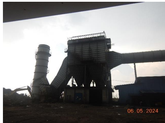
ภาพถ่ายที่ 2.2-2 เครื่องดักฝุ่นแบบถุงกรอง
