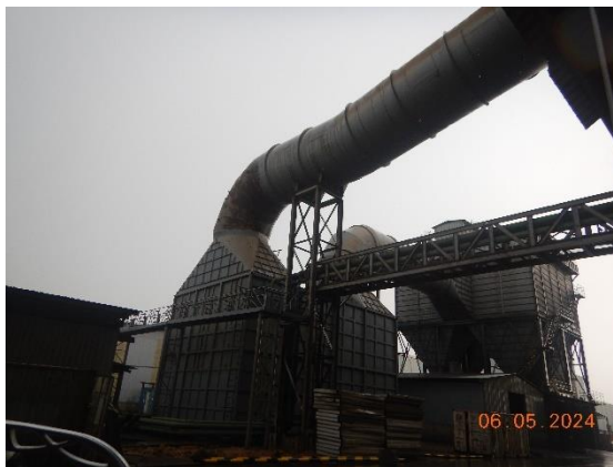
ภาพถ่ายที่ 2.2-2 เครื่องดักฝุ่นแบบถุงกรอง
