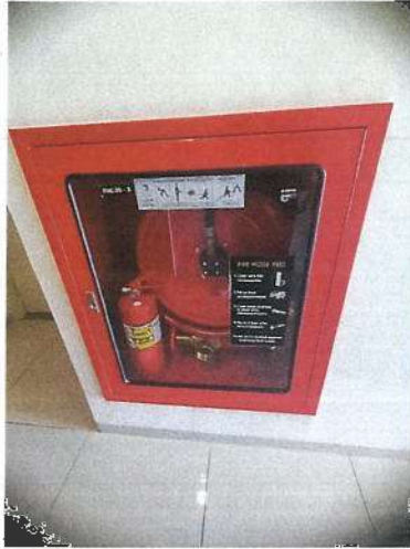
รูปที่ 2-31 เกือบสายฉีดน้ำดับเพลิงพร้อมอุปกรณ์
