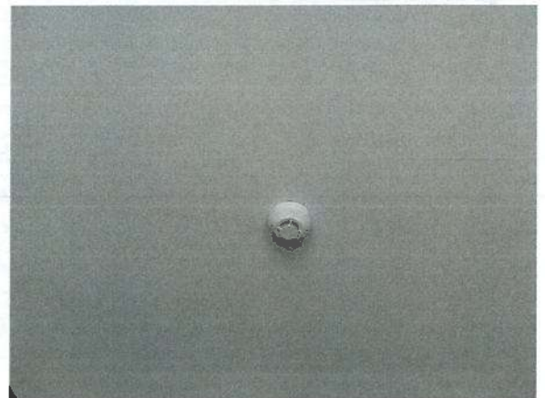
รูปที่ 2-36 เครื่องตรวจจับควัน (Smoke Detector)
