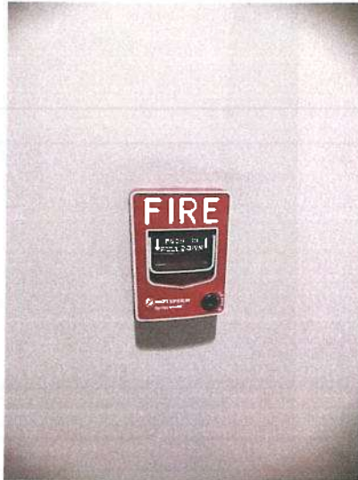
รูปที่ 2-37 เครื่องแจ้งเหตุโดยใช่มือดึง (Manual Station)
