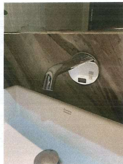
รูปที่ 2-12 ออกแบบโดยเลือกใช้สุขภัณฑ์ที่ประหยัด น้ำ
