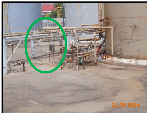
ภาพที่ 8 ระบบตรวจวัดความเป็นกรด - ด่างอัตโนมัติ และแสดงค่าไปที่ห้องควบคุม
