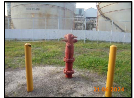
ภาพที่ 28 ติดตั้งระบบฉีดน้ำ และระบบโฟมภายในถังและ Hydrant สำหรับสารเคมี เพื่อใช้ในการดับเพลิง
