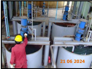
ภาพที่ 14 ระบบบำบัดน้ำเสีย ที่รองรับน้ำเสียจากหน่วยนำน้ำเสียกลับคืน โดยระบบบำบัดน้ำเสียแบบ Anaerobic System ชนิด UASB และ Aerobic System ชนิด Activated Sludge
