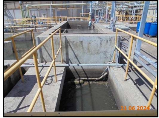
ภาพที่ 16 บ่อ API เพื่อรวบรวมน้ำระบายทิ้งจากระบบหล่อเย็น
