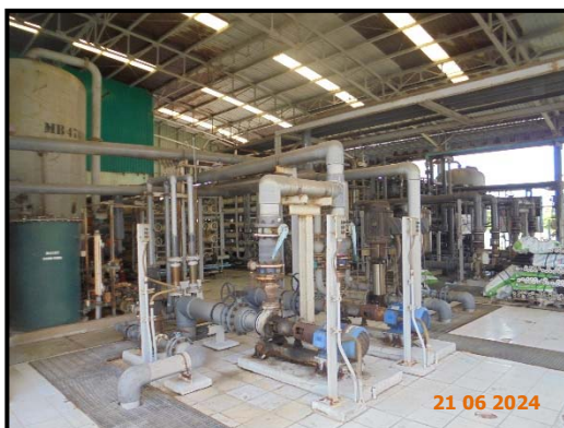
ภาพที่ 13 หน่วยนำน้ำเสียกลับคืน (Wastewater Recovery Unit) เพื่อนำน้ำเสียจากกระบวนการทำบริสุทธิ์ มาผลิตเป็นน้ำ RO
