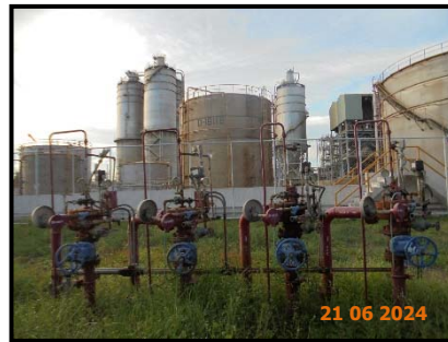
ภาพที่ 28 ติดตั้งระบบฉีดน้ำ และระบบโฟมภายในถังและ Hydrant สำหรับสารเคมี เพื่อใช้ในการดับเพลิง
