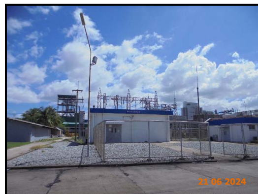
ภาพที่ 9 Main Sub-station สำหรับรับจ่ายไฟฟ้าระหว่าง หน่วยผลิต ยูทิลิตี้ส์ กับการไฟฟ้าส่วนภูมิภาค
