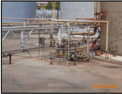
ภาพที่ 7 อุปกรณ์ตรวจจับไอระเหย Chemical Scrubbing Process
