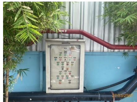
ภาพที่ 2.2-12 ตู้ควบคุมไฟฟ้าของระบบบำบัดน้ำเสีย
