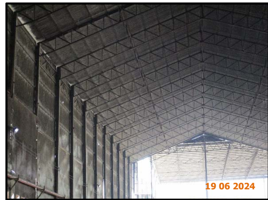
รูปที่ 3 ผนังกันลมบริเวณพื้นที่โกดังเก็บเชื้อเพลิง
