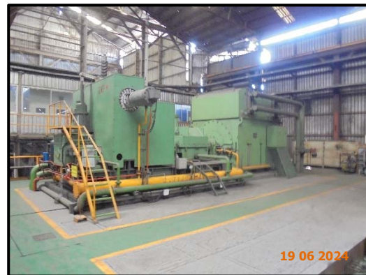
รูปที่ 13 เครื่องกำเนิดไฟฟ้ากังหันไอน้ำอยู่ในอาคารปิด
