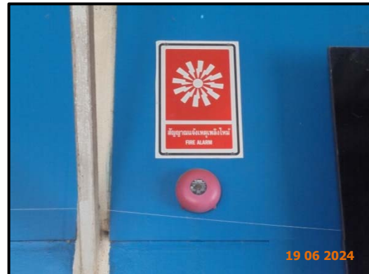
รูปที่ 19 สัญญาณเตือนภัยแบบอัตโนมัติ
