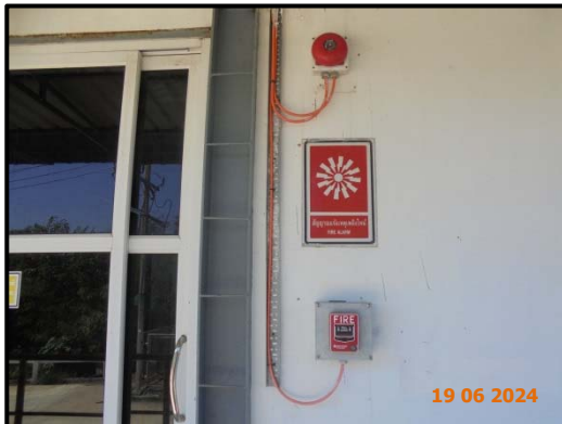
รูปที่ 19 สัญญาณเตือนภัยแบบอัตโนมัติ
