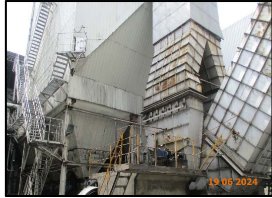
รูปที่ 1 ระบบดักฝุ่นแบบ Electrostatic Precipitation (ESP)
