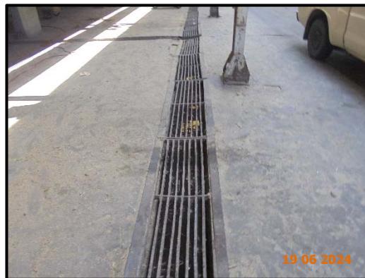
รูปที่ 16 ระบบระบายน้ำฝน
