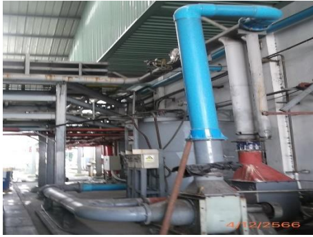
ภาพที่ 2.2-4 ระบบบำบัดกลิ่นภายในห้องสูบล้าง ของเสียที่เป็นของเหลวและระบบบำบัดอากาศ กรณีเตาเผาเกิดขัดข้อง
