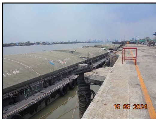
รูปที่ 5 ขอบคอนกรีต บริเวณท่าเทียบเรือ โดยรอบ และเทพื้นด้วยคอนกรีตเสริมเหล็ก
