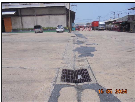
รูปที่ 3 รางระบายน้ำแบบมีตะแกรงดักขยะภายในพื้นที่โครงการ
