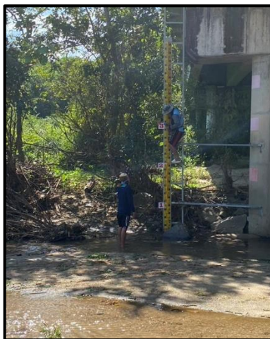
รูปที่ 5.2.1-3 การตั้งเลขบอกระดับหัวแผ่นวัดระดับน้ำ (Staff Guage)
