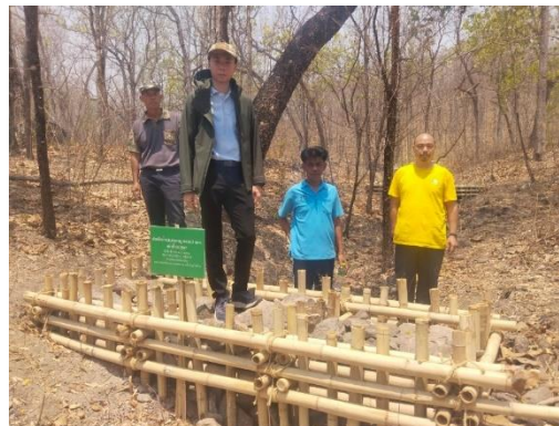
รูปที่ 5.1.2-1 การก่อสร้างฝายต้นน้ำแบบคอกหมู ขนาด 3 เมตร จำนวน 20 แห่ง
