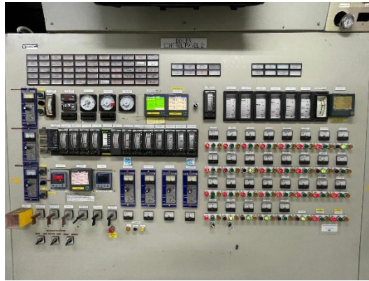
รูปที่ 12 ระบบการแจ้งเตือนกรณี ESP ทำงานขัดข้อง
