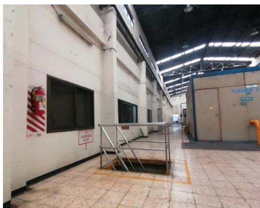
รูปที่ 20 ปิดครอบเครื่องจักรที่มีเสียงดัง
