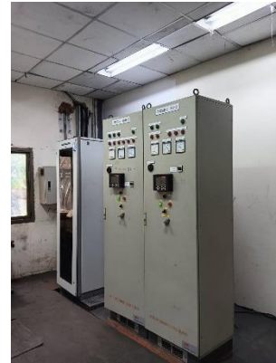
รูปที่ 12 ระบบการแจ้งเตือนกรณี ESP ทำงานขัดข้อง
