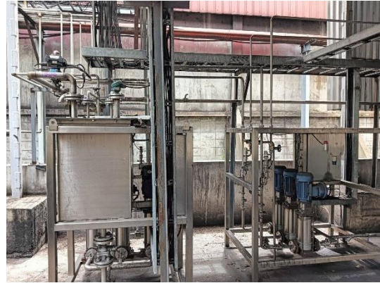
รูปที่ 9 การติดตั้งระบบฉีดพ่นสารละลายแอมโมเนียมไฮดรอกไซด์
