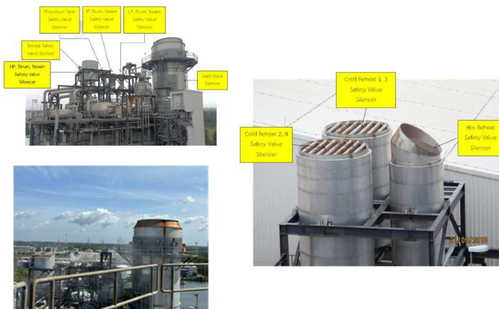
รูปที่ ค-6 ติดตั้งอุปกรณ์ลดเสียง (Silencer) บริเวณ HRSG โรงไฟฟ้าบางปะกง ชุดที่ 5 และบริเวณกังหันไอน้ำโรงไฟฟ้าบางปะกง ชุดที่ 5
