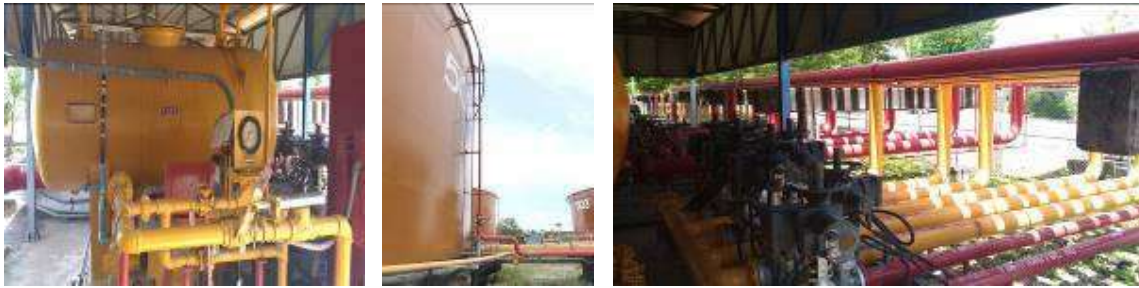
รูปที่ ค-52 ระบบโฟมอยู่บริเวณตรงข้ามกับอาคารทำกรนายนํ้า โดยจะมีท่อโฟมส่งไปที่ถังเก็บนํ้ามันทุกถัง
