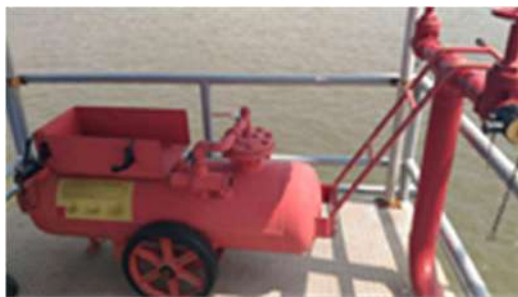
รูปที่ ค-49 เครื่องฉีดโฟมแบบเคลื่อนที่
