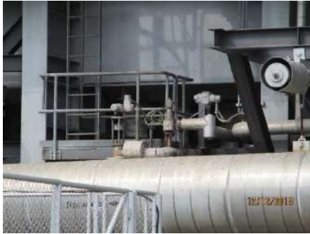
รูปที่ ค-39 Relief Valve
