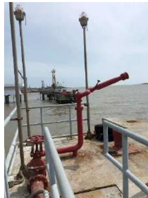
รูปที่ ค-45 เครื่องฉีดน้ำแบบตั้งอยู่กับที่
