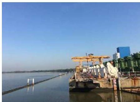
รูปที่ ค-22 พylonดักขยะบริเวณหน้าอาคารสูบน้ำเข้าระบบหล่อเย็นของโรงไฟฟ้า
