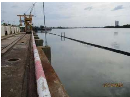
รูปที่ ค-22 พylonดักขยะบริเวณหน้าอาคารสูบน้ำเข้าระบบหล่อเย็นของโรงไฟฟ้า
