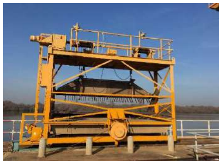
รูปที่ ค-21 เครื่องเก็บขยะบริเวณตะแกรงหน้าอาคารสูบน้ำเข้าระบบหล่อเย็นของโรงไฟฟ้า
