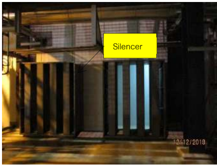
รูปที่ ค-7 ติดตั้งอุปกรณ์ลดเสียง (Silencer) บริเวณ Steam Turbine Enclosure โรงไฟฟ้าบางปะกง ชุดที่ 5
