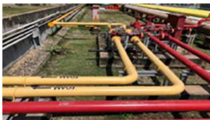
รูปที่ ค-55 ระบบหัวกระจายน้ำดับเพลิงแบบอัตโนมัติ ด้วยสารละลายโฟม
