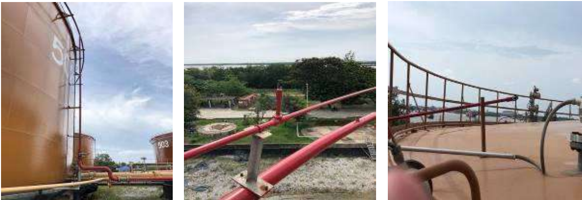
รูปที่ ค-53 ระบบ Water Spray ติดตั้งที่ถังเก็บนํ้ามันทุกถัง
