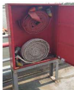
รูปที่ ค-47 หัวจ่ายน้ำดับเพลิงและสายยางขนาด 2.5 นิ้ว อยู่ภายในตู้ Hydrant บริเวณปลายท่า
