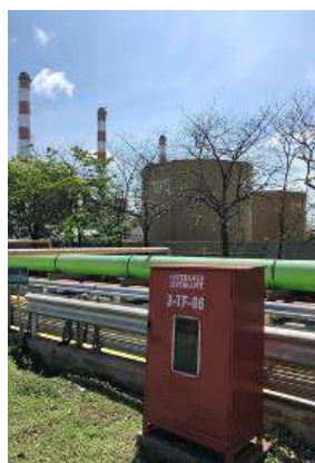
รูปที่ ค-57 หัวจ่ายน้ำดับเพลิง Hydrant ติดตั้งบริเวณรอบนอกของถังเก็บน้ำมัน
