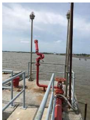
รูปที่ ค-45 เครื่องฉีดน้ำแบบตั้งอยู่กับที่
