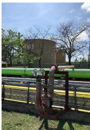
รูปที่ ค-57 หัวจ่ายน้ำดับเพลิง Hydrant ติดตั้งบริเวณรอบนอกของถังเก็บน้ำมัน
