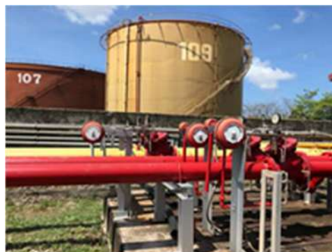
รูปที่ ค-54 ระบบกระจายนํ้าดับเพลิงแบบอัตโนมัติ
