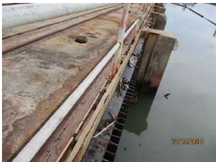
รูปที่ ค-21 เครื่องเก็บขยะบริเวณตะแกรงหน้าอาคารสูบน้ำเข้าระบบหล่อเย็นของโรงไฟฟ้า
