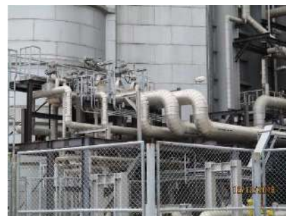
รูปที่ ค-29 ฉนวนป้องกันความร้อน (Insulation) และการปิดคลุม (Enclosures) แหล่งกำเนิดความร้อน
