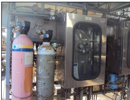
รูปที่ 2-4 ระบบการติดตามตรวจสอบ NO x จากปล่อง GTG-3+HRSG-3
