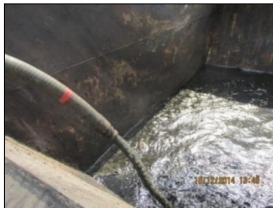
รูปที่ 2-21 การขุดลอกตะกอนในบ่อบำบัดปี พ.ศ. 2557
