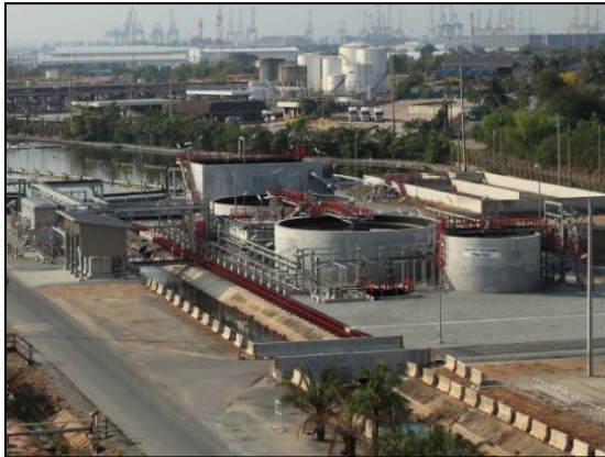
รูปที่ 2-14 ระบบ Activated Sludge (AS)
