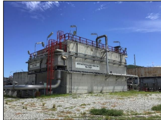
รูปที่ 2-14 ระบบ Activated Sludge (AS)
