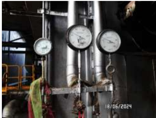
รูปที่ 43 มาตรวัดความดันไอน้ำ/มาตรวัดระดับน้ำ
