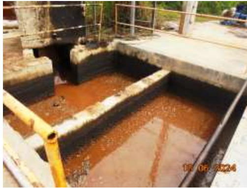
รูปที่ 18 ระบบแยกน้ำและน้ำมัน (Oil Separator)
