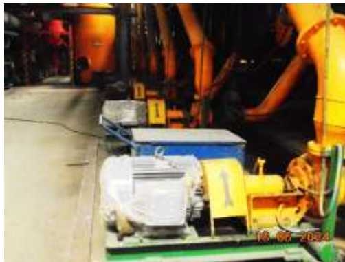
รูปที่ 33 การติดตั้งการป้องกันอันตรายบริเวณเครื่องจักร
