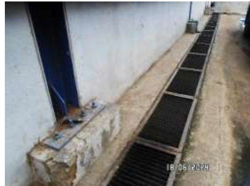
รูปที่ 18 ระบบแยกน้ำและน้ำมัน (Oil Separator)
