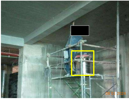
รูปที่ 2-66 การใช้เครื่องดูดฝุ่นที่แหล่งกำเนิด
