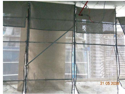
รูปที่ 2-65 การติดตั้ง Mesh Sheet (แบบกันไฟลาม)
