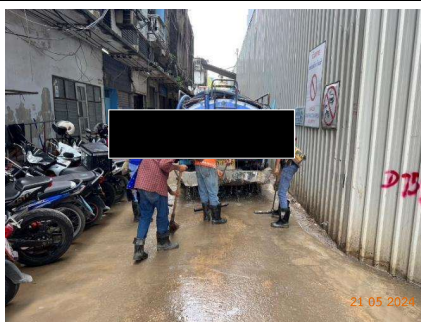
รูปที่ 2-13 การฉีดพรมน้ำและทำความสะอาดบริเวณถนน รอบพื้นที่ก่อสร้างเพื่อลดฝุ่นละออง
