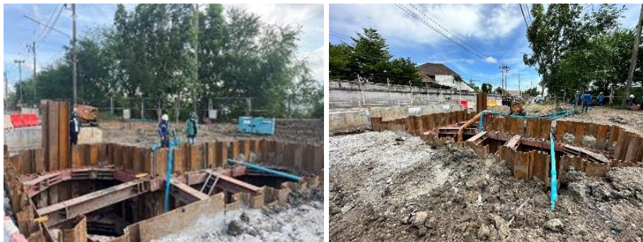
รูปที่ ค-17 ติดตั้งเครื่องมือหรืออุปกรณ์ป้องกันการถล่มของดิน ในการขุดร่องวางท่อส่งก๊าซธรรมชาติ
