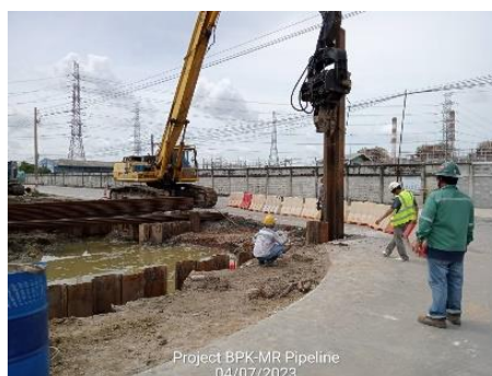
รูปที่ ค-18 โครงการมีการจัดให้มีเจ้าหน้าที่ควบคุมดูแลการรื้อถอน Sheet Pile
