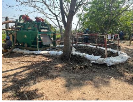
รูปที่ ค-27 โครงการมีการวางถุงทรายหรือจัดทำคันดินกันรอบพื้นที่ เพื่อป้องกันตะกอนลงสู่คลองขุดลอก
