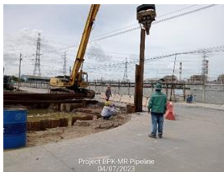
รูปที่ ค-72 ตรวจสอบไม่ให้มีสิ่งกีดขวางหรือผู้ปฏิบัติงานที่อยู่ในระยะที่อาจเกิดอันตรายจากการยกท่อลงร่องชุด
