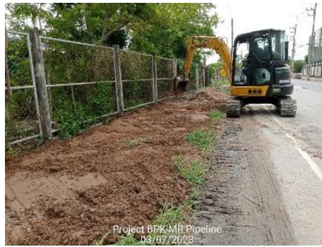
รูปที่ ค-19 โครงการมีการฝังกลบท่อในแต่ละช่วงของการก่อสร้างแล้วเสร็จ
