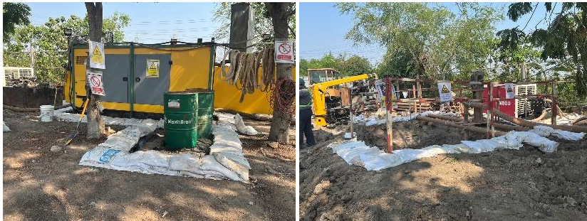
รูปที่ ค-28 จัดวางถุงทรายเพื่อป้องกันโคลนโซเดียมเบนโทไนท์จากการขุดเจาะปนเปื้อนออกสู่แหล่งน้ำพื้นที่ใกล้เคียง
