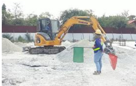
รูปที่ ค-70 กำหนดผู้ทำหน้าที่ขับรถขุด และขุดอย่างระมัดระวังไม่ให้ถูกสิ่งที่อยู่ในแนวขุด
