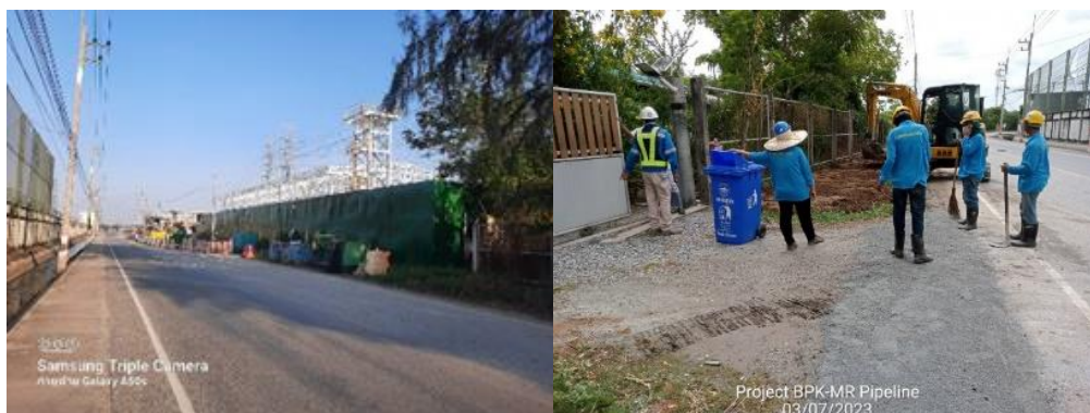
ปที ค-3 ดำเนินการฝังกลบหน้าดินและคืนพื้นที่ หลังจากวางท่อแล้วเสร็จ
