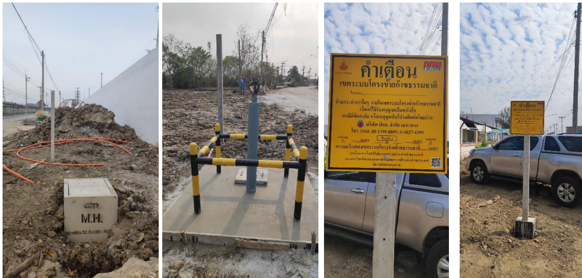
รูปที่ ค-95 โครงการติดตั้งป้ายเตือนและฝังแผ่นคอนกรีตเหนือแนวท่อเพื่อแสดงให้เห็นว่ามีท่อส่งก๊าซฝังอยู่
