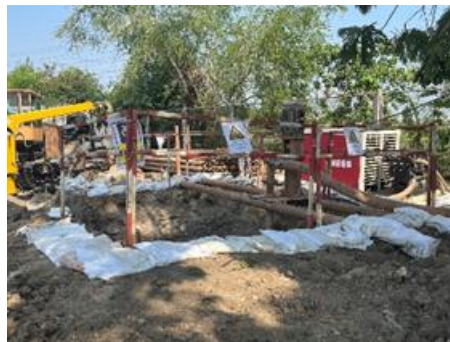
รูปที่ ค-21 โครงการมีการกันพื้นที่โดยการจัดวางถุงทรายขณะมีการก่อสร้างบ่อรับ-บ่อส่ง
