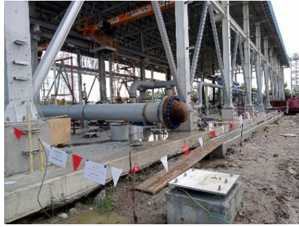
รูปที่ ค-75 กั้นเขตบริเวณพื้นที่ที่มีการเชื่อมต่อ พร้อมทั้งติดตั้งเครื่องหมายเตือนแสดงเขตที่อาจเกิดอันตราย
