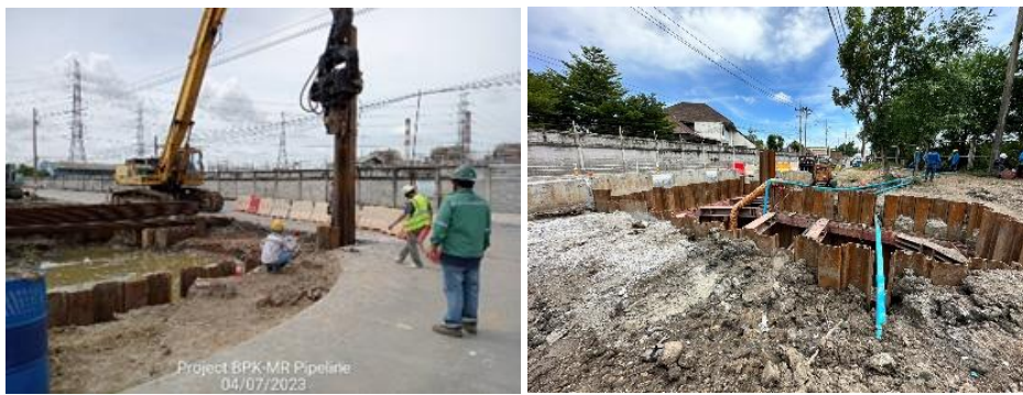
รูปที่ ค-68 มีการควบคุมและมีมาตรการป้องกันดินถล่มที่เกิดจากการขุดเปิดพื้นที่
