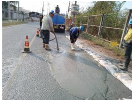
รูปที่ ค-24 โครงการมีการเตรียมรถสำหรับดูดโคลนโซเดียมเบนโทไนท์ กรณีเกิดการรั่วไหล
