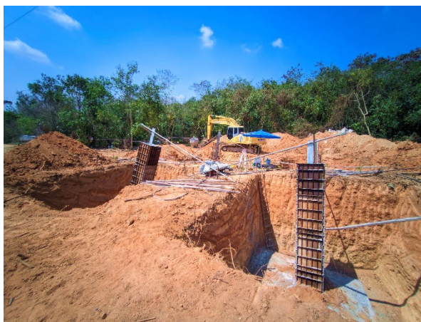
รูปที่ 1.15 การก่อสร้างฐานรากในช่วงที่ 1 ของโครงการระบบโครงข่ายไฟฟ้า 230 กิโลโวลต์ จุดเชื่อมบางละมุง2 – บางละมุง2 ในพื้นที่ป่าสงวนแห่งชาติป่าบางละมุง
