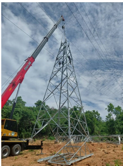
รูปที่ 1.16 การก่อสร้างโครงเสาในช่วงที่ 1 ของโครงการระบบโครงข่ายไฟฟ้า 230 กิโลโวลต์ จุดเชื่อมบางละมุง2 – บางละมุง2
