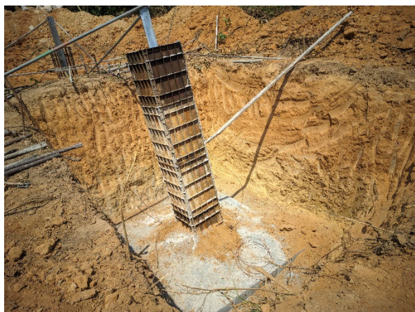
รูปที่ 1.15 การก่อสร้างฐานรากในช่วงที่ 1 ของโครงการระบบโครงข่ายไฟฟ้า 230 กิโลโวลต์ จุดเชื่อมบางละมุง2 – บางละมุง2 ในพื้นที่ป่าสงวนแห่งชาติป่าบางละมุง
