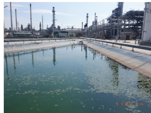
รูปที่ 2-10 บ่อพักน้ำ (Surge Pond) ของโรงงานปรับปรุงภาพน้ำเสียรวมของบริษัท ไทยออยล์ จำกัด (มหาชน)
