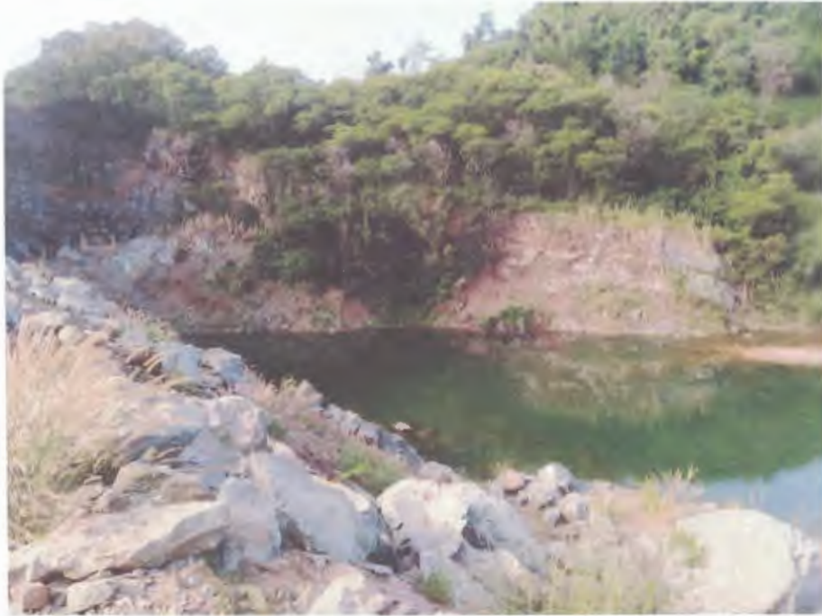
รูปที่ 16 บ่อคักตะกอน ด้านตะวันออกเฉียงเหนือของพื้นที่ทำเหมือง ใช้รองรับปริมาณน้ำขุนชั้นที่ชะล้างผ่านบริเวณหน้าเหมือง
