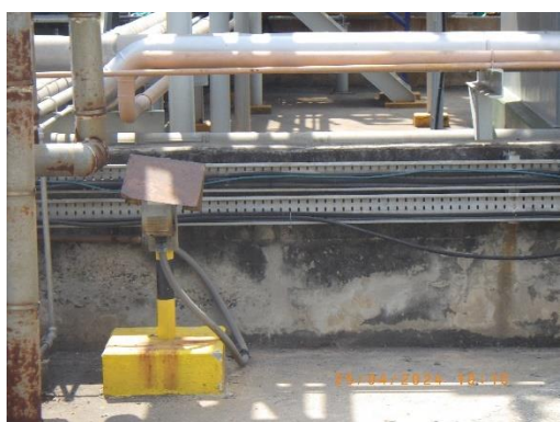
รูปที่ 2-92 Flammable Gas Detector
