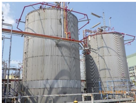
รูปที่ 2-85 ถังเก็บก๊าซสารไฮโดรคาร์บอน 5 อะตอม
