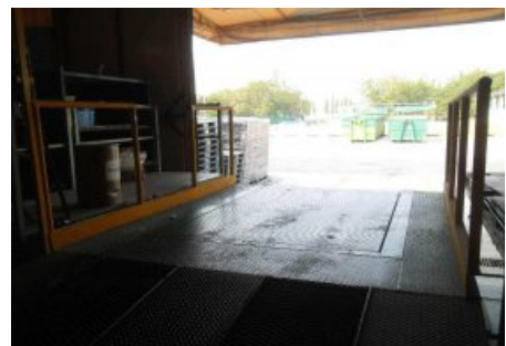
รูปที่ 5 การติดตั้งราวกันตก ณ จุดโหลดสินค้า
