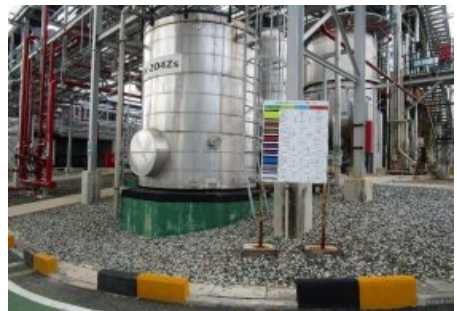
รูปที่ 18 ภาพ Color Code ของแนวท่อต่างๆ ในเขตการผลิต
