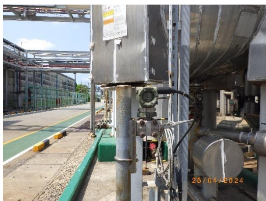
รูปที่ 2-98 เกจวัดระดับอัตโนมัติของถังเก็บกัก เทอร์เทียรี บิวทิลคลอไรด์
