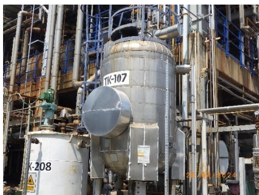
รูปที่ 2-96 การบุผนังภายนอกด้วยแผ่น โพลีเอโซไซยานูเรตแทนโฟมของถังเก็บกัก สารเทอร์เทียรีบิวทิลคลอไรด์
