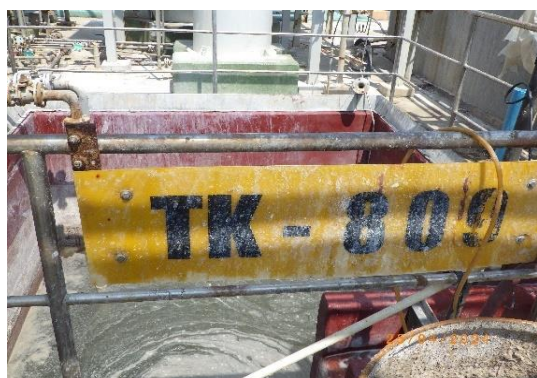
บ่อพักน้ำทิ้ง (Wastewater Hold Up Tank)
