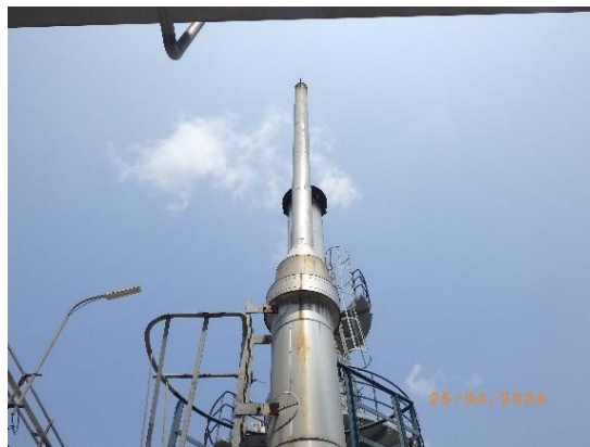
เตาความร้อนของระบบถ่ายเทความร้อน ด้วยน้ำมันร้อน (Heat Transfer Fluid Boiler) ติดตั้งระบบ Low NOx Burner
