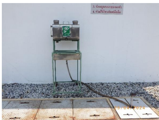
รูปที่ 2-35 ระบบแยกน้ำมัน (Oil Separator) พื้นที่อาคารเก็บกากของเสีย
