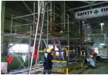
รูปที่ 7 การติดตั้งรั้วและกันพื้นในการทำงาน
