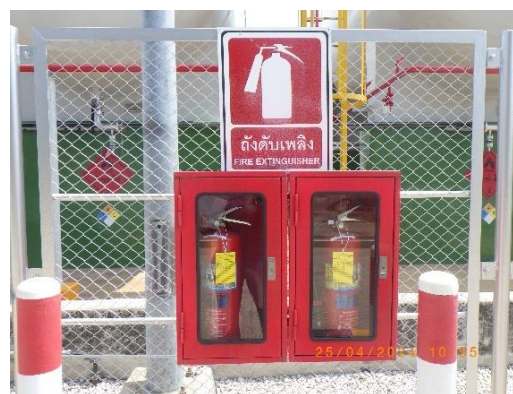
รูปที่ 2-60 ถังดับเพลิงชนิดมือถือผงแห้ง (Portable Dry Powder Extinguisher) ประเภท ABC
