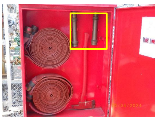
รูปที่ 2-57 อุปกรณ์ดับเพลิง (หัวฉีดน้ำดับเพลิง (Portable Water Spray))
