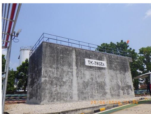
รูปที่ 2-55 บ่อน้ำสำรองดับเพลิง ขนาด 364 ลูกบาศก์เมตร
