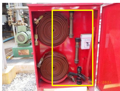
รูปที่ 2-57 อุปกรณ์ดับเพลิง (หัวฉีดน้ำดับเพลิง (Portable Water Spray))
