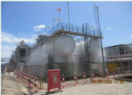
รูปที่ 16 ภาพการทดสอบระบบสปริงเกอร์
