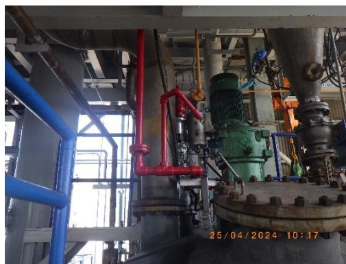
รูปที่ 2-81ท่อระบายก๊าซภายในถังเกิดปฏิกิริยาไปเผาที่ Waste Gas Incinerator
