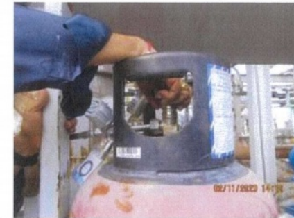
ภาพที่ 3 แสดงให้เห็นการเปลี่ยนถังแอมโมเนียโดยปิดวาล์วที่ตัวถังของจุดที่ 1 RE-701Zs (Boiler ZCT-2)
