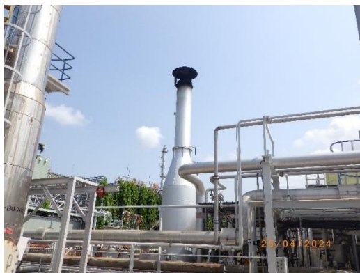
เตาเผาก๊าซเสียจากกระบวนการผลิต (Waste Gas Incinerator) ติดตั้งระบบ Low NOx Burner รูปที่ 2-4 (ต่อ) ระบบบำบัดมลพิษอากาศ สายการผลิตที่ 1 (ZCT-1)
