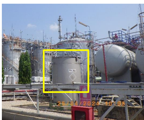
รูปที่ 2-100 ถังด่าง (NaOH)
