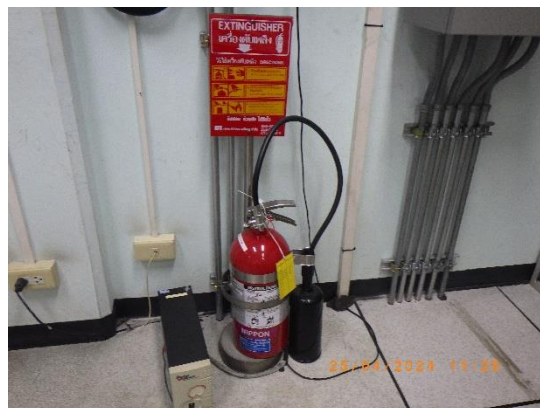
รูปที่ 2-64 ถังดับเพลิงสำหรับอุปกรณ์ อิเล็กทรอนิกส์ บริเวณภายในห้องควบคุม
