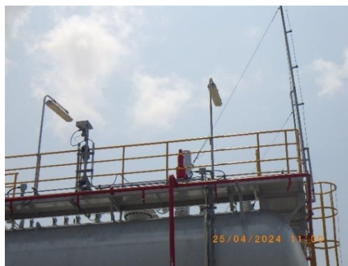
รูปที่ 2-89 Safety Valve บริเวณถัง C4M
