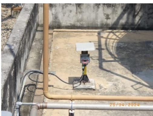
รูปที่ 2-111 Gas Detector ถังกักเก็บเมธิลไซโคลเฮกเซน
