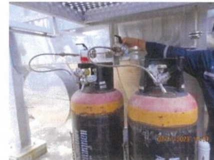
ภาพที่ 4 แสดงให้เห็นถังบรรจุแอมโมเนีย และการเปลี่ยนถังแอมโมเนียโดยปิดวาล์วท่อแก๊สของ จุดที่ 2 RE-701 (Boiler ZCT-1)
