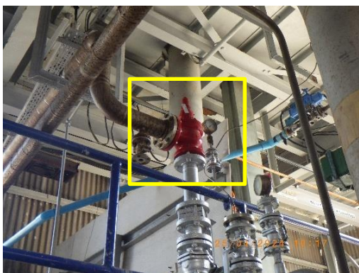
รูปที่ 2-80 Safety Valve ถังปฏิกิริยา
