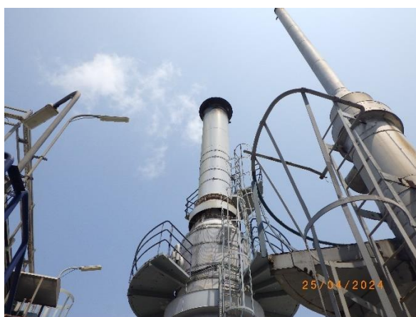
เตาเผาก๊าซเสียจากกระบวนการผลิต (Waste Gas Incinerator) ติดตั้งระบบ Low NOx Burner รูปที่ 2-5 ระบบบำบัดมลพิษอากาศ สายการผลิตที่ 2 (ZCT-II)
