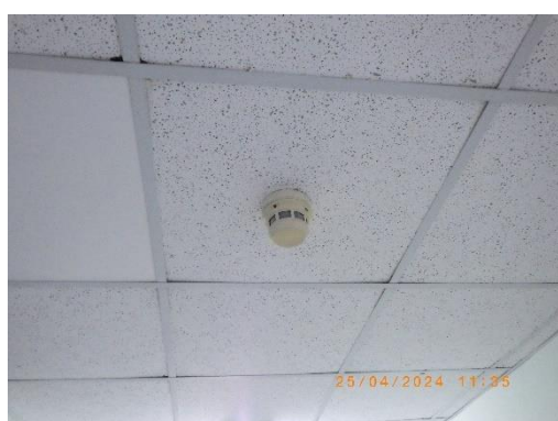
รูปที่ 2-51 Smoke detector
