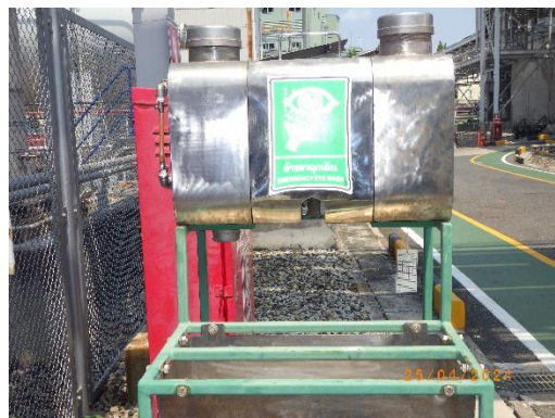
รูปที่ 2-69 Emergency Safety Shower/ Hand Shower/Emergency eye washer
