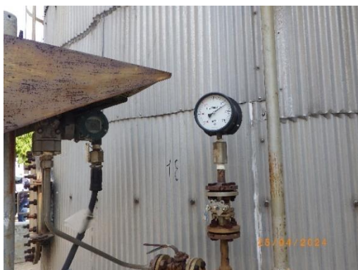
รูปที่ 2-88 อุปกรณ์วัดระดับ (Level transmitter)
