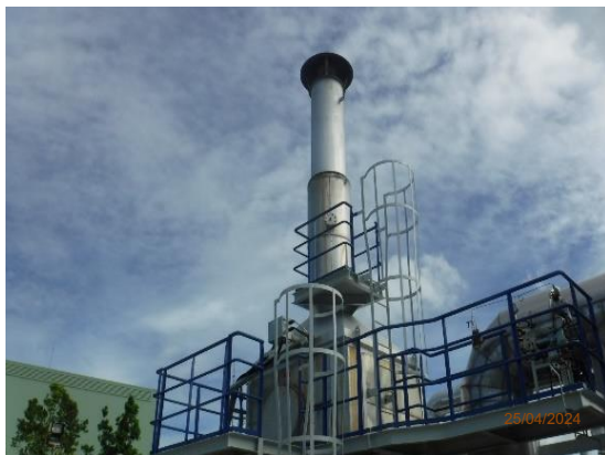
หม้อผลิตไอน้ำ (Steam Boiler) ติดตั้งระบบ Selective Catalytic Reduction (SCR)
