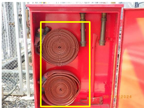
รูปที่ 2-63 ม้วนสายฉีดน้ำดับเพลิง (Indoor Hose Reel System)
