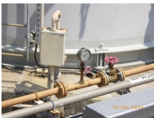
รูปที่ 2-112 เกจวัดระดับสารในถังกักเก็บ เมธิลไซโคลเฮกเซน
