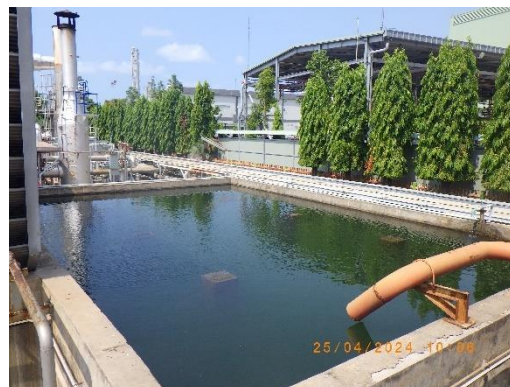
รูปที่ 2-54 แหล่งน้ำสำรองดับเพลิงขนาด 312 ลูกบาศก์เมตร
