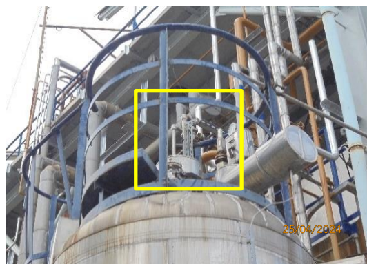
รูปที่ 2-97 อุปกรณ์ระบายความดัน Safety Valve บริเวณด้านบนของถังเก็บกักสารเทอร์เทียรีบิวทิลคลอไรด์
