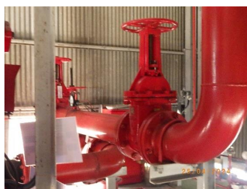
รูปที่ 2-52 เครื่องสูบน้ำดับเพลิง ชนิดดีเซล
