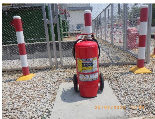
รูปที่ 2-62 ถังดับเพลิงชนิดมีล้อชนิดผงแห้ง (Wheeled Dry Powder Extinguisher) ประเภท ABC ขนาด 50 กิโลกรัม
