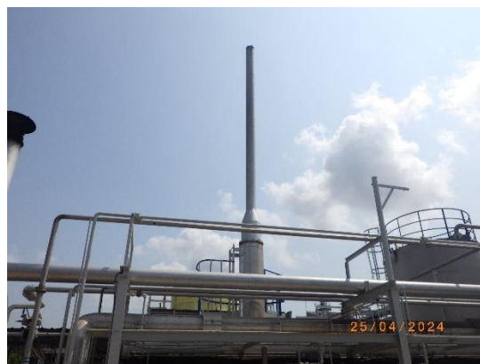
เตาความร้อนของระบบถ่ายเทความร้อนด้วยน้ำมันร้อน (Heat Transfer Fluid Boiler)
