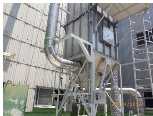
รูปที่ 2-2 ระบบดักฝุ่นแบบถุงกรองบริเวณ Packing
