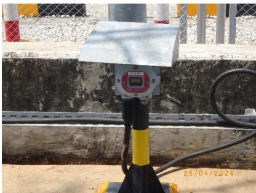
รูปที่ 2-107 Gas detector บริเวณลานถัง C4
