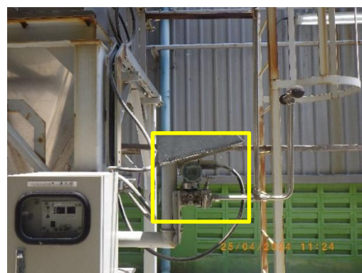
รูปที่ 2-3 เครื่องวัดความดันของระบบดักฝุ่นแบบถุงกรอง
