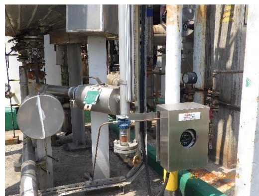
รูปที่ 2-99 อุปกรณ์ตรวจวัดการรั่วไหลของก๊าซไวไฟ (Flammable Gas Detector) บริเวณสารเทอร์เทียรี บิวทิลคลอไรด์
