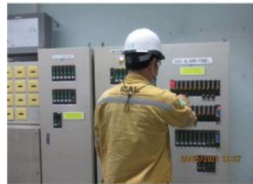
รูปที่ 41 ภาพการตรวจสอบระบบ Gas Detector
