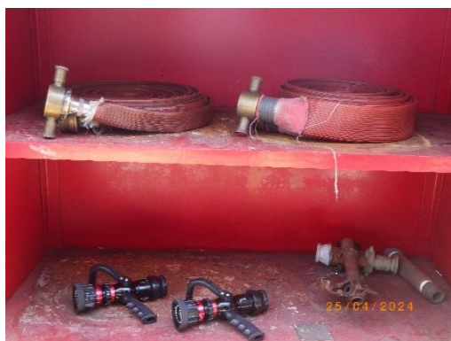
รูปที่ 2-65 หัวฉีดน้ำดับเพลิงแบบฝอย (Spray Viper)
