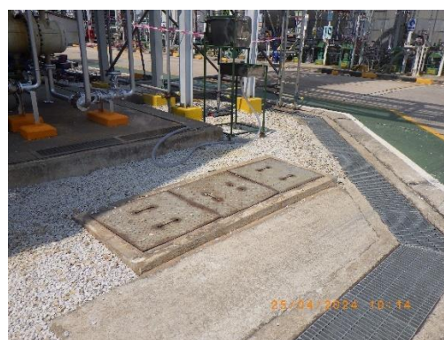
รูปที่ 2-9 Oil Separator สายการผลิตที่ 1
