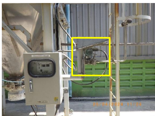
รูปที่ 2-3 เครื่องวัดความดันของระบบดักฝุ่นแบบถุงกรอง
