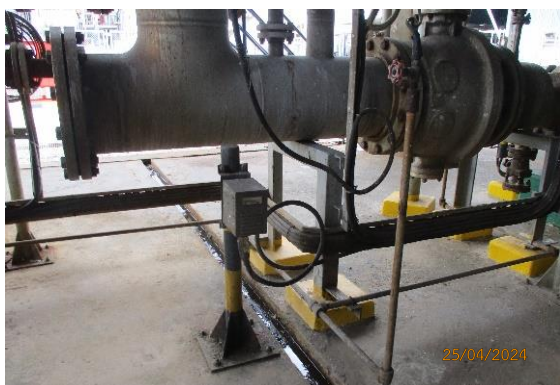
รูปที่ 2-1 ระบบตรวจจักษ์ก๊าซ Hydrocarbon
