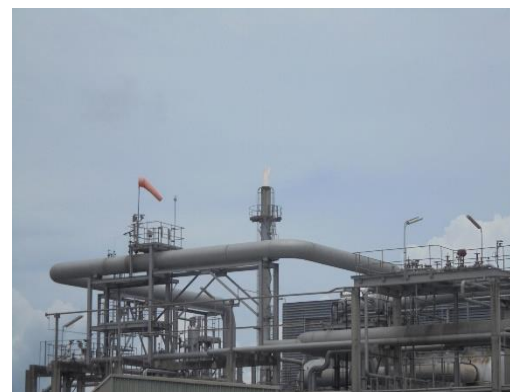
รูปที่ 2-6 ระบบหอเผาของ บริษัท ไทยพาราไชลีน จำกัด
