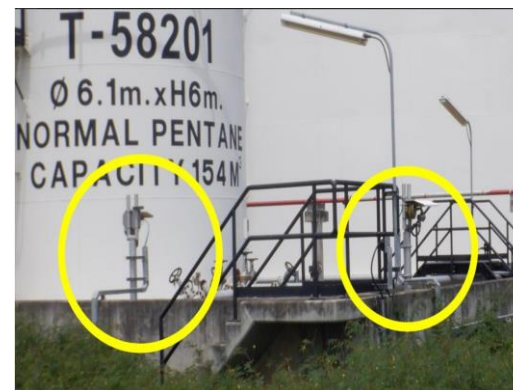
รูปที่ 2-29 ระบบตรวจจับก๊าซพิษในพื้นที่กระบวนการผลิต
