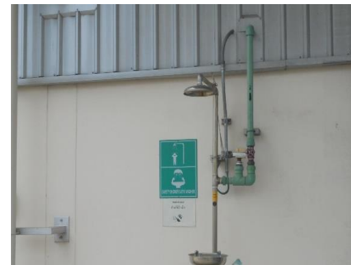
รูปที่ 2-27 ฝักบัวอาบน้ำ ล้างตา จุกเงิน
