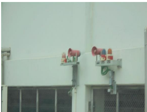
รูปที่ 28 ระบบสัญญาณเตือนเหตุฉุกเฉิน
