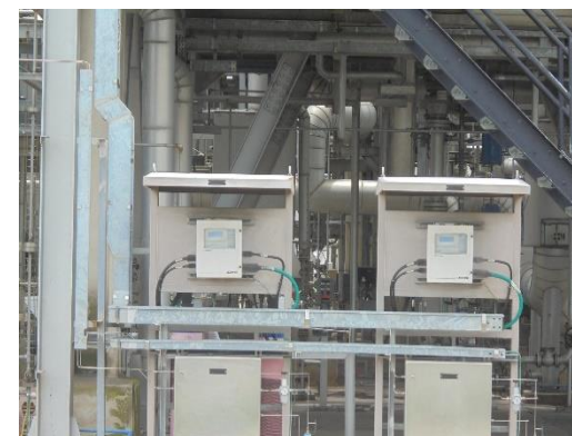
รูปที่ 2-4 การติดตั้งระบบตรวจวัดคุณภาพอากาศแบบต่อเนื่อง (CEMS)
