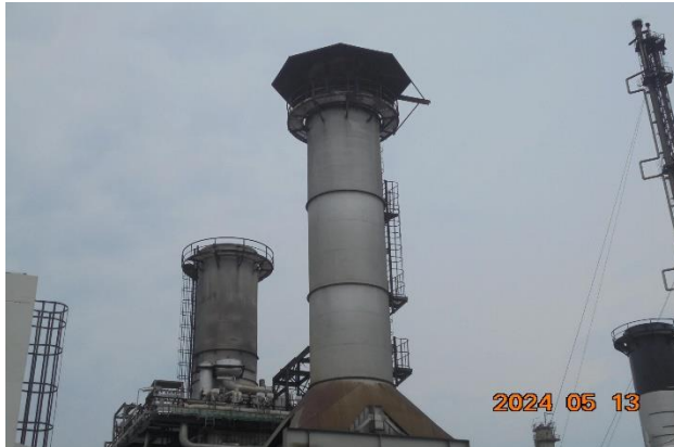
รูปที่ 2-1 ปล่องระบายอากาศเสียสูง 30 เมตร
