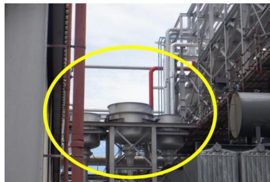
รูปที่ 2-7 (ต่อ) โครงการติดตั้ง Silencers จำนวน 5 แห่ง
