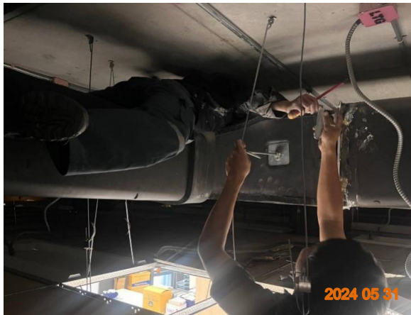
รูปที่ 2-51 ตรวจสอบการรั่วของท่อลม
