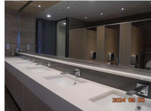
รูปที่ 2-11 เลือกใช้อุปกรณ์ประหยัดน้ำเช่น โกลุขภัณฑ์ ก๊อกน้ำ เป็นต้น
