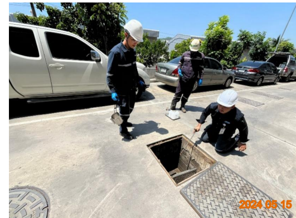
รูปที่ 2-54 ตรวจสอบปริมาณตะกอนที่สะสมบริเวณท่อระบายน้ำในพื้นที่โครงการ
