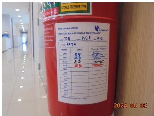
รูปที่ 2-45 ตรวจสอบประสิทธิภาพของอุปกรณ์สำหรับระบบดับเพลิง เป็นประจำทุกเดือน
