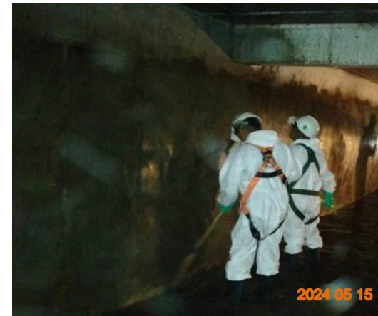
รูปที่ 2-52 ล้างทำความสะอาดถึงสํารองน้ำใช้ทุกแห่ง
