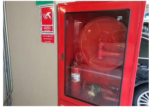
ตู้เก็บสายน้ำดับเพลิงพร้อมอุปกรณ์
