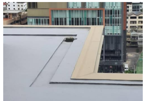
ภาพที่ 2.2-30 ตะแกรงครอบท่อระบายน้ำโครงการ
