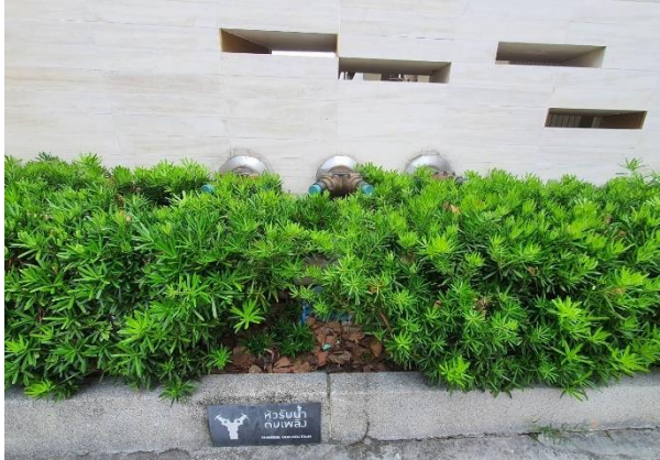
จุดเชื่อมต่อท่อประปาของการประปานครหลวง ภาพที่ 1.3.4-1 ระบบน้ำใช้
