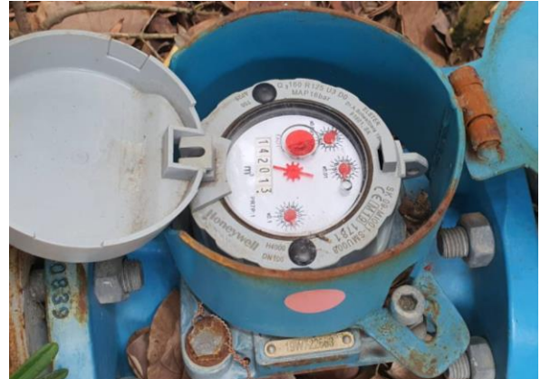
จุดเชื่อมต่อท่อประปาของการประปานครหลวง ภาพที่ 1.3.4-1 ระบบน้ำใช้
