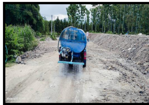
รูปที่ 2-30 การฉีดพรมน้ำ
