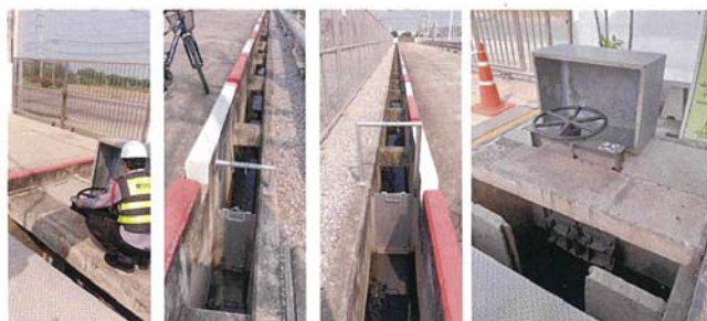
เวลา 9.46 น. รปภ. ปิดประตูน้ำกันรางระบายน้ำฝนเรียบร้อย
