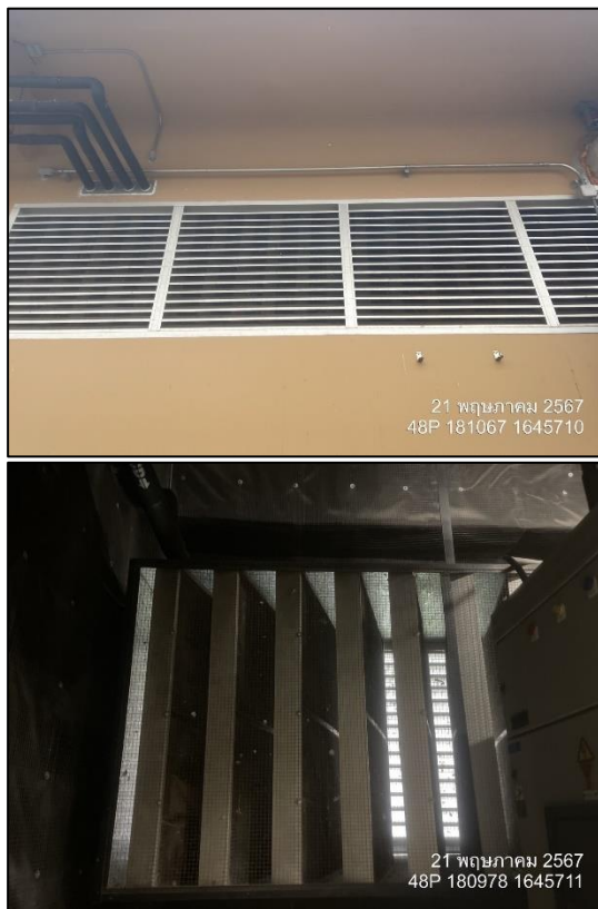
รูปที่ 2.2-14 ประตูลมดูดอากาศ และพัดลมดูดอากาศภายในห้องเครื่องกำเนิดไฟฟ้า
