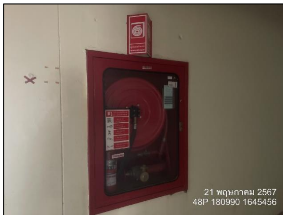
รูปที่ 2.2-32 อุปกรณ์ดับเพลิง สายส่งน้ำ (Fire Hose) ยาว 30 เมตร ภายในโครงการ
