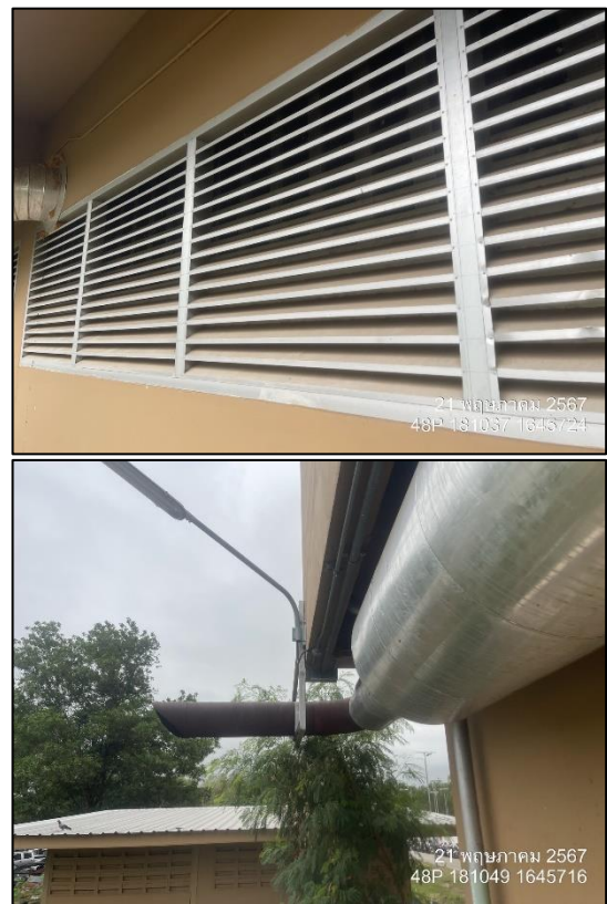
รูปที่ 2.2-14 ประตูลมดูดอากาศ และพัดลมดูดอากาศภายในห้องเครื่องกำเนิดไฟฟ้า
