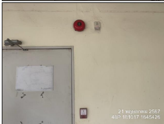
รูปที่ 2.2-30 ระบบสัญญาณเตือนเพลิงไหม้โดยมือ กริ่งสัญญาณเตือนไฟไหม้
