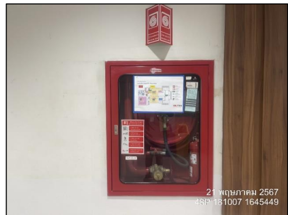
รูปที่ 2.2-32 อุปกรณ์ดับเพลิง สายส่งน้ำ (Fire Hose) ยาว 30 เมตร ภายในโครงการ
