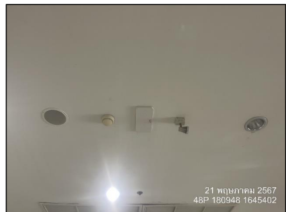
รูปที่ 2.2-30 ระบบสัญญาณเตือนเพลิงไหม้โดยมือ กริ่งสัญญาณเตือนไฟไหม้
