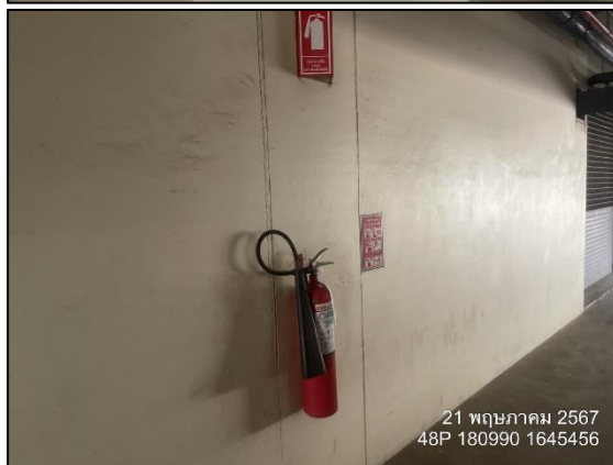
รูปที่ 2.2-33 ถังดับเพลิงเคมีชนิดมือถือ
