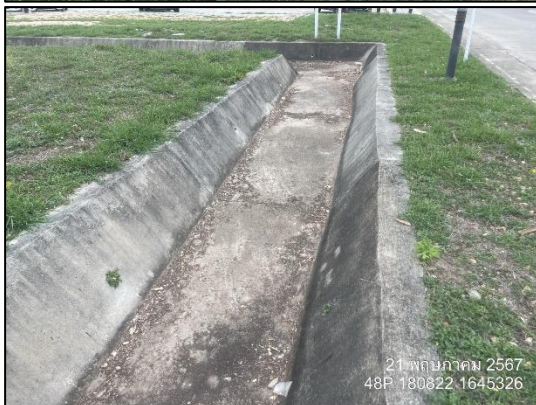
รูปที่ 2.2-21 รางระบายน้ำฝนของโครงการ
