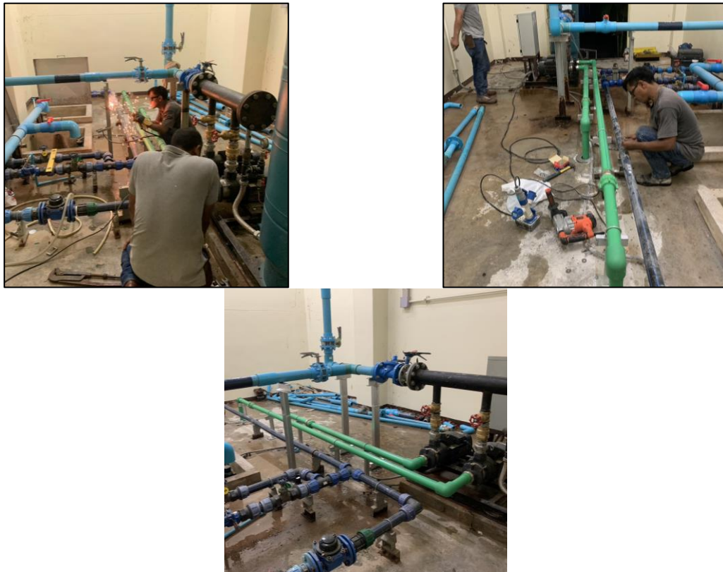
รูปที่ 2.2-18 เจ้าหน้าที่ตรวจสอบระบบส่งจ่ายน้ำประปา และดำเนินการซ่อมแซม
