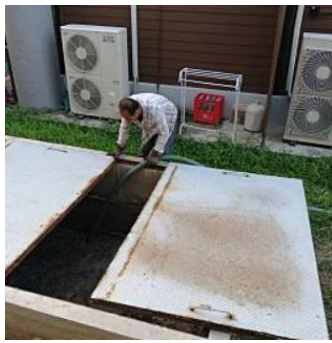
รูปที่ 2.2-22 บ่อดักไขมันหลังอาคารโรงอาหารและการทำความสะอาดบ่อดักไขมัน
