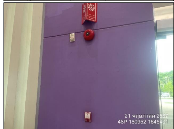
รูปที่ 2.2-30 ระบบสัญญาณเตือนเพลิงไหม้โดยมือ กริ่งสัญญาณเตือนไฟไหม้
