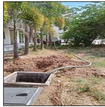
รูปที่ 2.2-22 บ่อดักไขมันหลังอาคารโรงอาหารและการทำความสะอาดบ่อดักไขมัน
