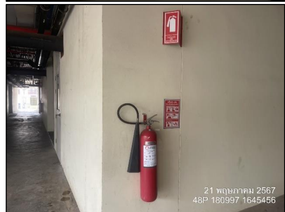
รูปที่ 2.2-33 ถังดับเพลิงเคมีชนิดมือถือ
