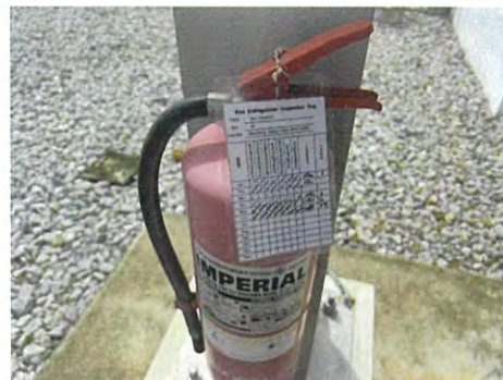
ภาพที่ 2-2 เครื่องดับเพลิงบริเวณสถานีก๊าซ บริเวณสถานีควบคุมความดันและวัดปริมาณก๊าซธรรมชาติ
