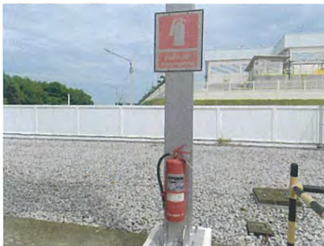
ภาพที่ 2-2 เครื่องดับเพลิงบริเวณสถานีก๊าซ บริเวณสถานีควบคุมความดันและวัดปริมาณก๊าซธรรมชาติ
