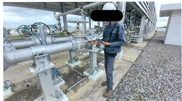
ภาพที่ 2-6 การตรวจวัดก๊าซในจุดที่ปฏิบัติงานด้วย Gas Detector
