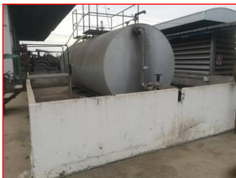
ภาพที่ 2.2-16 กำแพงกันดักเก็บน้ำมันโซล่า (Bound Wall)
