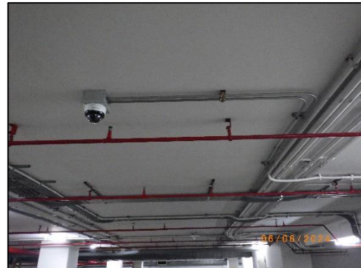
ค) ระบบดับเพลิงอัตโนมัติแบบโปรยน้ำฝอย
