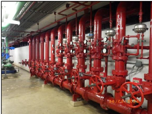
ค) ระบบดับเพลิงอัตโนมัติแบบโปรยน้ำฝอย
