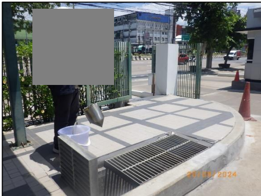
รูปที่ 17 ป่อพักก่อนระบายน้ำทิ้งลงสู่ท่อระบายน้ำสาธารณะ
