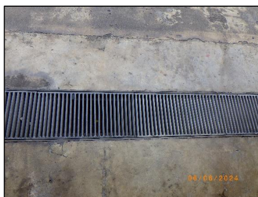
รูปที่ 3 ห้องพักรวมมูลฝอยและรางระบายน้ำจากห้องพักรวมมูลฝอย
