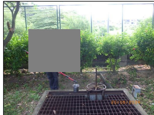
รูปที่ 17 ป่อพักก่อนระบายน้ำทิ้งลงสู่ท่อระบายน้ำสาธารณะ
