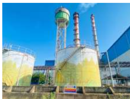
ภาพที่ 2-59 คันคอนกรีตรอบบริเวณถังน้ำมันและถังบรรจุสารเคมี
