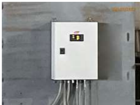
ภาพที่ 2-2 ติดตั้ง Oxygen Analyzer
