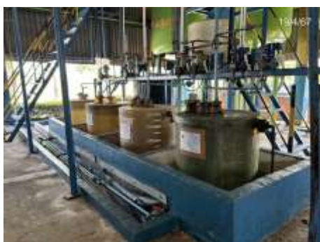
ภาพที่ 2-59 คันคอนกรีตรอบบริเวณถังน้ำมันและถังบรรจุสารเคมี
