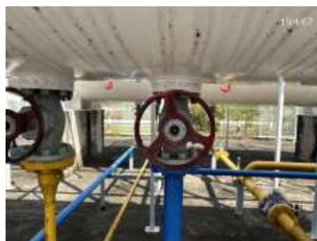
ภาพที่ 2-57 ป้ายทิศทางการหมุนของวาล์ว และทิศทางการไหลในท่อขนส่ง
