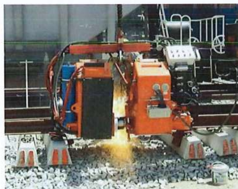
รูปแสดงวิธีการเตรียมการเชื่อมรางโดยวิธี Flash Butt
