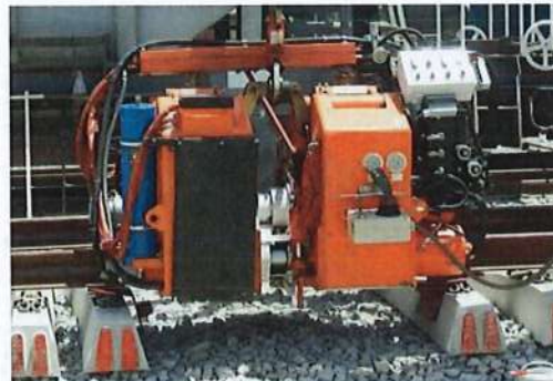
รูปแสดงการวัดระยะหมอนและติดตั้งแผ่นป้องกันสะเก็ดไฟ
