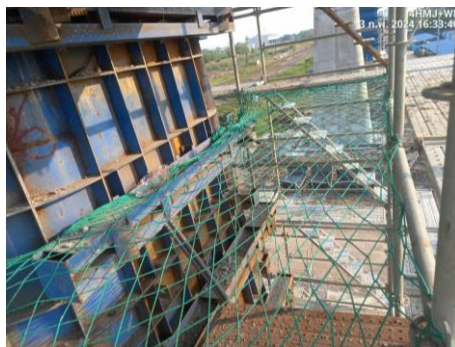
ภาพที่ 2.2-49 การติดตั้ง Safety Net
