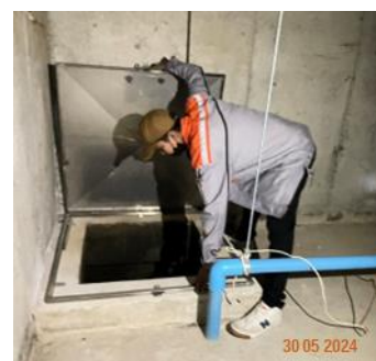
ภาพที่ 2.2-13 ทำความสะอาดถังเก็บน้ำ
