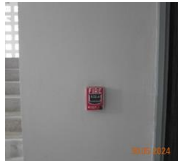
อุปกรณ์ส่งสัญญาณเพื่อให้หนีไฟ
