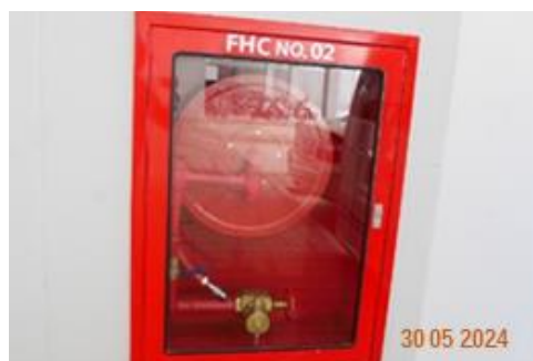
ตู้เก็บสายฉีดน้ำดับเพลิงและหัวจ่ายน้ำ
