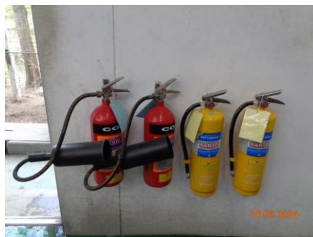
ภาพที่ 2.2-33 ถังดับเพลิง Class D บริเวณโรงคัดแยกเศษอะลูมิเนียม
