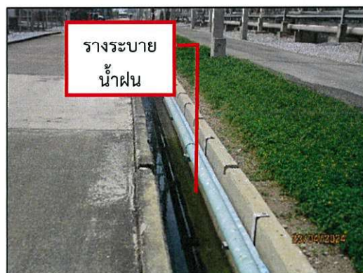
ภาพถ่ายที่ 2.2-18 รางระบายรวบรวมน้ำฝน ท่อระบายน้ำเสีย
