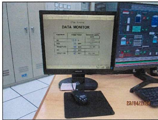
ภาพถ่ายที่ 2.2-4 ระบบแสดงการเตือน Alarm เพื่อควบคุมค่าอัตราการระบาย \text{NO}_x
