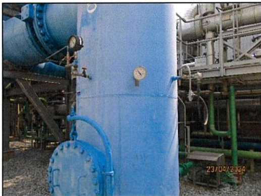
ภาพถ่ายที่ 2.2-12 เครื่องวัดอุณหภูมิของหอหล่อเย็น
