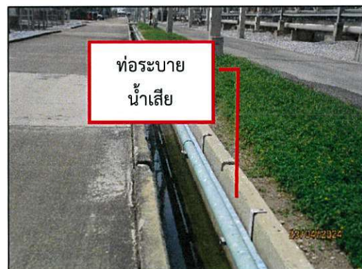
ภาพถ่ายที่ 2.2-18 รางระบายรวบรวมน้ำฝน ท่อระบายน้ำเสีย
