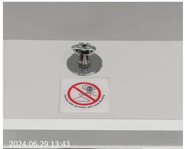
ภาพที่ 2.26 ระบบตรวจจับควัน (Smoke Detector) และระบบดับเพลิงอัตโนมัติ (Sprinkler)
