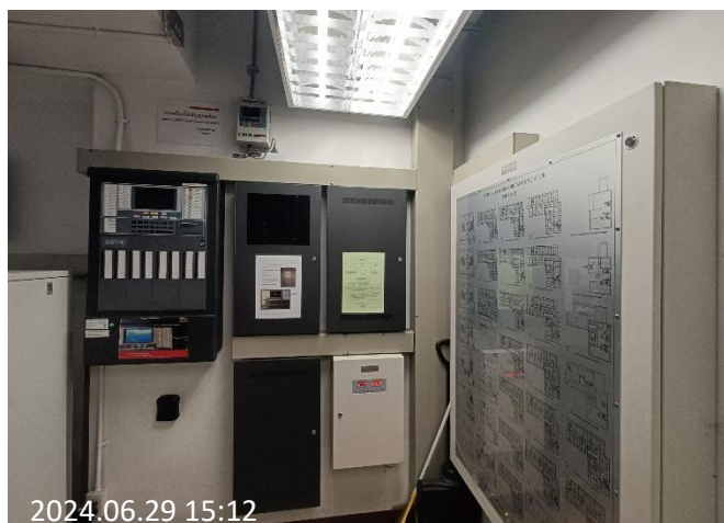
ภาพที่ 2.37 Fire Alarm System
