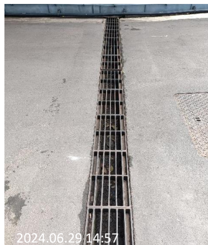
ภาพที่ 2.13 ตะแกรงดักขยะ
