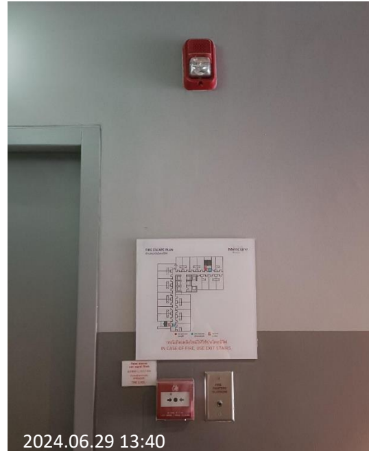
ภาพที่ 2.19 สัญญาณแจ้งเตือนเหตุเพลิงไหม้
