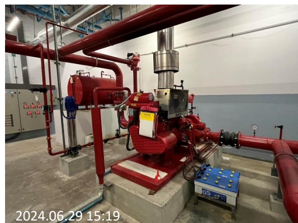
ภาพที่ 2.38 Fire Water Pump
