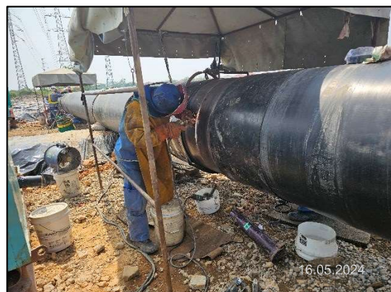
ค) การเชื่อมต่อส่งก๊าซในกิจกรรมการวางท่อโดย วิธีการดันลอดระยะยาว
