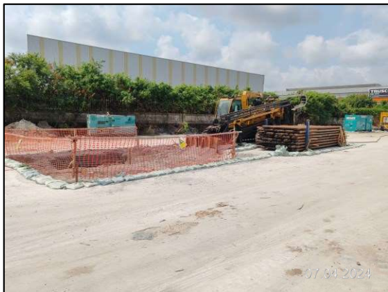
ข) การจัดเตรียมเครื่องมือในกิจกรรมการวางท่อ โดยวิธีการเจาะลอด
