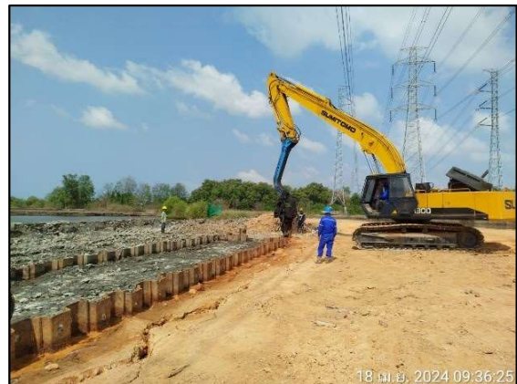
ค) การติดตั้ง Sheet pile ในกิจกรรมการวางท่อ โดยวิธีการดันลวดระยะยาว
