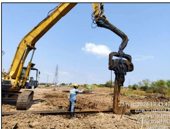
ข) การติดตั้ง Sheet pile ในกิจกรรมการวางท่อ โดยวิธีการดันลวด
