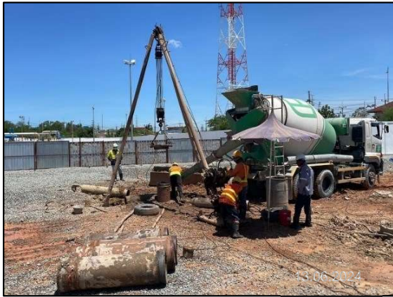
ก. การตอกเสาเข็มในกิจกรรมการก่อสร้าง สถานีควบคุมก๊าซ
