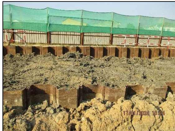
ข) การฝังกลบหลังการวางท่อสำหรับการวางท่อโดยวิธีการดันลอดระยะยาว
