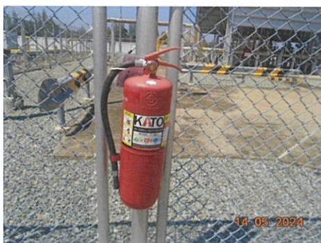
ภาพที่ 2-3 ถังดับเพลิงแบบเคมีผง และ Tag ตรวจสอบถังดับเพลิงแบบเคมีผง
