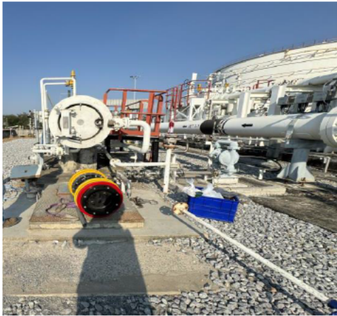
รูปที่ 2-2 การทำความสะอาดท่อน้ำมันด้วย Cleaning Pig
