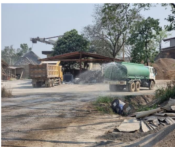
รูปที่ 2-18 การฉีดพรมน้ำในพื้นที่โครงการเพื่อป้องกันการฟุ้งกระจายของฝุ่นละออง (ภาพกิจกรรมล่าสุด)
