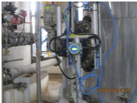
รูปที่ 26 เครื่องตรวจจับก๊าซ (Hydrocarbon Gas Detector)
