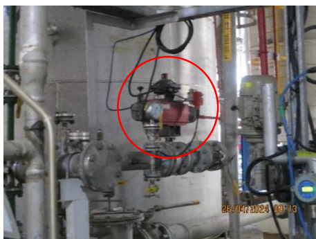
รูปที่ 24 ระบบ Interlock
