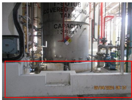
รูปที่ 14 ภาชนะรอง/คันคอนกรีตรอบถังบรรจจุสารเคมี
