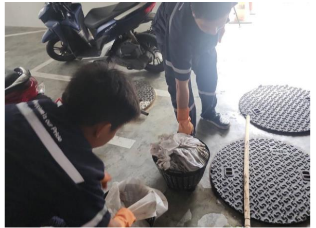
รูปที่ 20 เจ้าหน้าที่ตรวจเช็คบ่อดักไขมันและดักไขมัน
