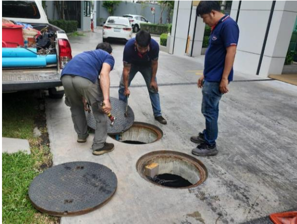
รูปที่ 25 ตรวจสอบเช็คสภาพบ่อพัก
