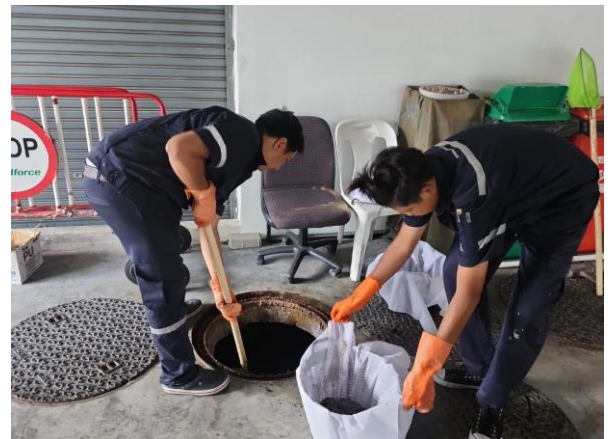
รูปที่ 18 เจ้าหน้าที่ตรวจสอบท่อตกไขมันและดักไขมัน
