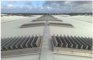
การติดตั้งช่องระบายบนหลังคาของอาคารโรงงาน
