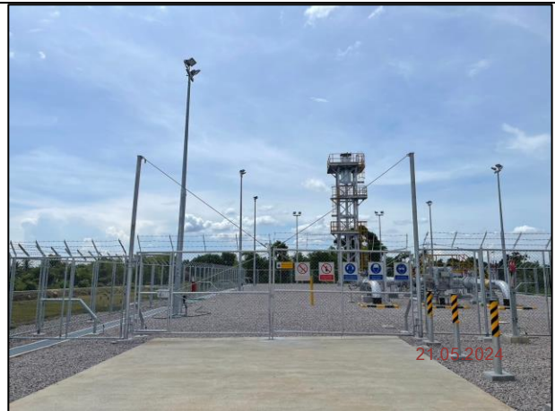
สถานีที่ 2 สถานีกลางทาง (Intermediate Block Valve Station)
