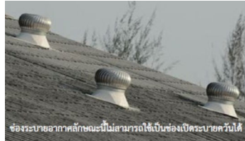
ช่องระบายอากาศลักษณะนี้ไม่สามารถใช้เป็นช่องเปิดระบายควันได้
