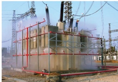
การทำงานของระบบหัวกระจายน้ำดับเพลิงแบบเปิด เพื่อป้องกันเพลิงไหม้ของหม้อแปลงไฟฟ้าชนิดน้ำมัน
