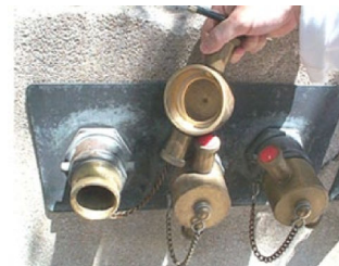
หัวรับน้ำดับเพลิงชนิดข้อต่อสวมเร็วขนาด 2.5 นิ้ว
