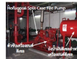
การขับเคลื่อนเครื่องสูบน้ำดับเพลิงด้วยเครื่องยนต์ดีเซล และมอเตอร์ไฟฟ้า
