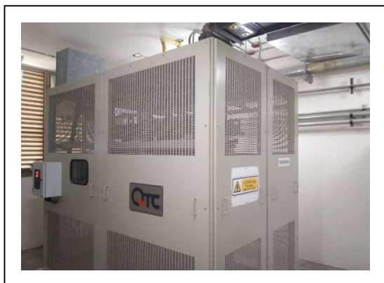
รูปที่ 2.1-33 ติดตั้งระบบไฟฟ้ารวมทั้งหม้อแปลงไฟฟ้า บริเวณชั้น 2 อาคาร B
