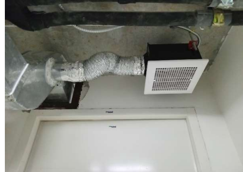
รูปที่ 2.1-28 ติดตั้งพัดลมดูดอากาศจากห้องพักรวมมูลฝอยของโครงการฯ
