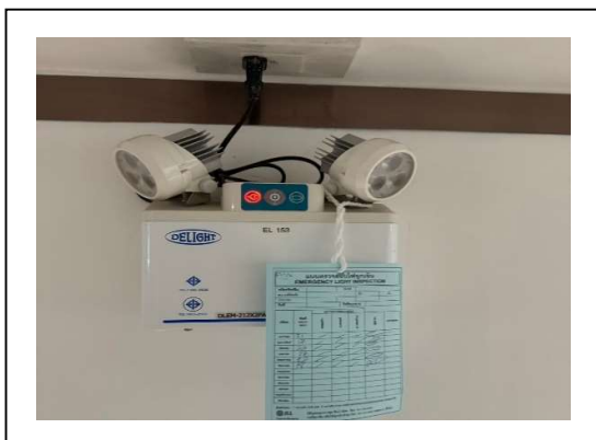
รูปที่ 2.1-47 ติดตั้งไฟฟ้าส่องสว่าง เพื่อให้มองเห็นช่องทางเดินได้
