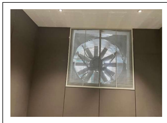
รูปที่ 2.1-52 ตรวจสอบช่องระบายอากาศภายในอาคาร ไม่ให้มีสิ่งกีดขวางการระบายอากาศ
