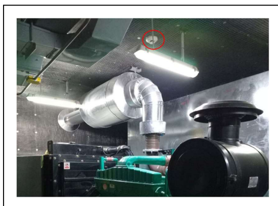
รูปที่ 2.1-36 ติดตั้งเครื่องตรวจจับควัน (Smoke Detector) ภายในห้องเครื่องไฟฟ้า
