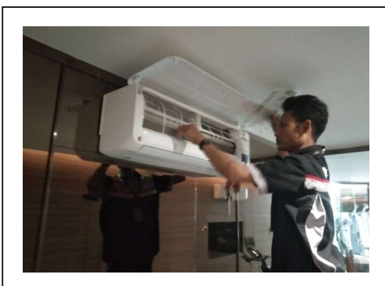
รูปที่ 2.1-53 ล้างแผ่นกรองอากาศของเครื่องปรับอากาศ แบบเต็มระบบเป็นประจำสม่ำเสมอ
