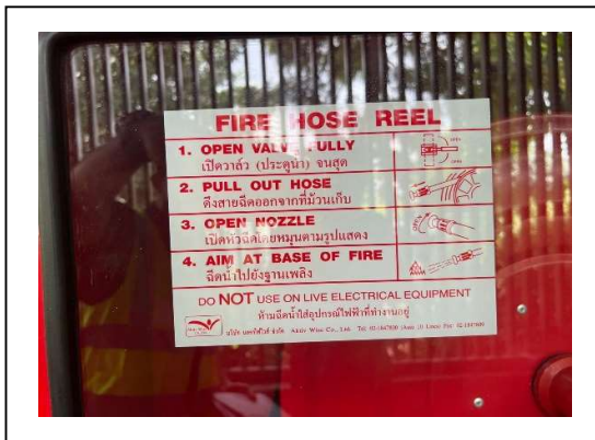
รูปที่ 2.1-45 ติดตั้งป้ายแนะนำการใช้อุปกรณ์ไว้ที่อุปกรณ์ติดตั้งอยู่
