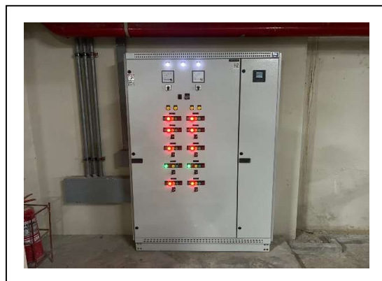
รูปที่ 2.1-18 ระบบมิเตอร์ไฟฟ้าสำหรับระบบบำบัดน้ำเสียของโครงการโดยเฉพาะ แยกจากระบบไฟฟ้าอื่นๆ
