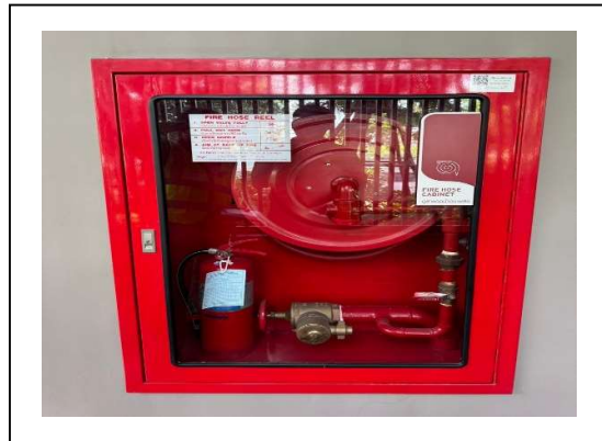
รูปที่ 2.1-44 ติดตั้งตู้เก็บอุปกรณ์ดับเพลิงในที่สังเกตเห็นได้ชัดเจน (จุดที่ 2)
