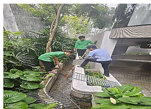
รูปที่ 2.1-42 การขุดลอกตะกอนสะสมภายในท่อระบายน้ำภายในโครงการและท่อระบายน้ำด้านหน้าโครงการ
