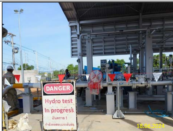
ง) การทดสอบท่อด้วยวิธีทางชลสถิต (Hydrostatic Test)
