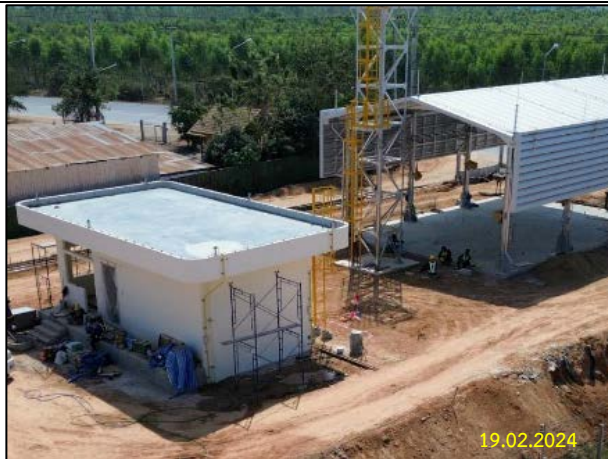
ค) การก่อสร้างสถานีควบคุมความดันและวัดปริมาตรก๊าซธรรมชาติ (Gate Station) และสถานีควบคุมก๊าซธรรมชาติ (Block Valve Station)
