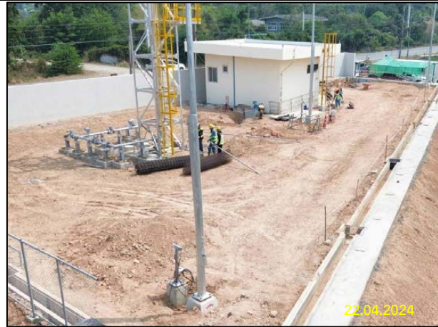
ก) การก่อสร้างสถานีควบคุมความดันและวัดปริมาตรก๊าซธรรมชาติ (Gate Station) และสถานีควบคุมก๊าซธรรมชาติ (Block Valve Station)
