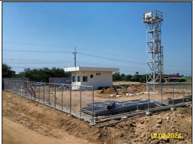
ค) การก่อสร้างสถานีควบคุมความดันและวัดปริมาตรก๊าซธรรมชาติ (Gate Station) และสถานีควบคุมก๊าซธรรมชาติ (Block Valve Station)
