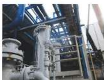
รูปอุปกรณ์ควบคุมความดันที่สถานีที่ควบคุมระบบ
