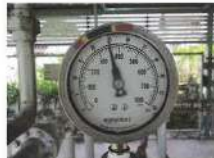
รูปความดันหลังจากอุปกรณ์ปรับลดแรงดัน
