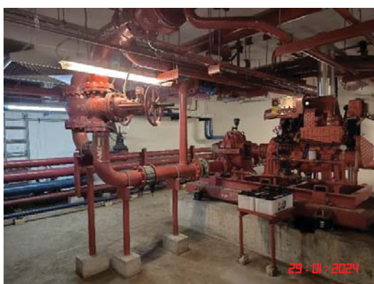
ระบบท่อเย็นและเครื่องสูบน้ำดับเพลิง
