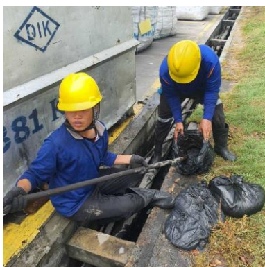
รูปที่ 12 การทำความสะอาดรางระบายน้ำ
