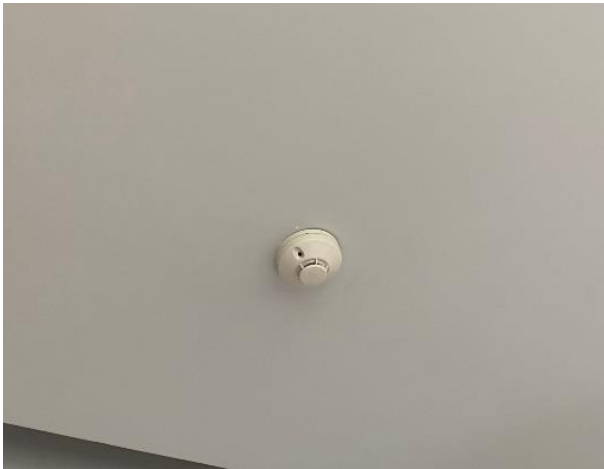
เครื่องตรวจจับความร้อน (Heater Detective)
