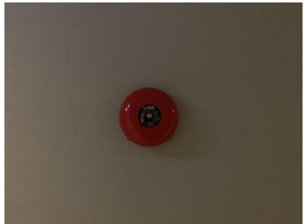
กระดิ่งเตือนภัย (Fire Alarm Bell)
