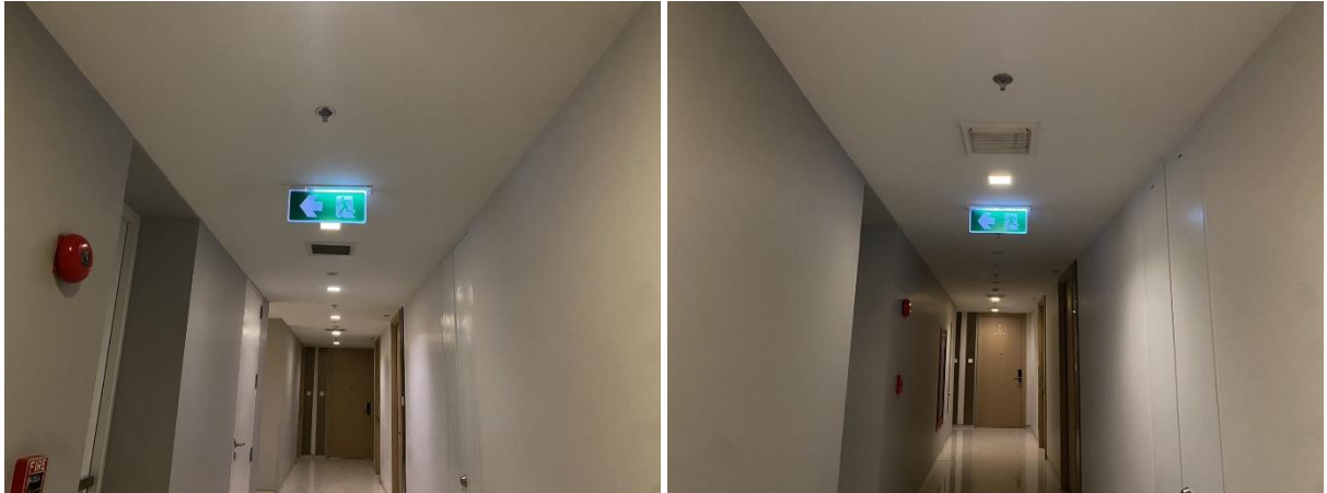
รูปที่ 24 ป้ายบอกทางหนีไฟภายในอาคาร
