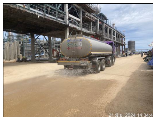
รูปที่ 2-2 การฉีดพรมน้ำในพื้นที่ก่อสร้างเพื่อลดการฟุ้งกระจายของฝุ่น
