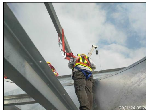
รูปที่ 2-62 การสวมใส่เข็มขัดนิรภัยสำหรับการทำงานบนที่สูง
