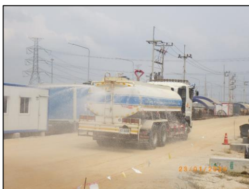
รูปที่ 2-2 การฉีดพรมน้ำในพื้นที่ก่อสร้างเพื่อลดการฟุ้งกระจายของฝุ่น
