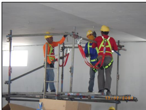
รูปที่ 2-62 การสวมใส่เข็มขัดนิรภัยสำหรับการทำงานบนที่สูง
