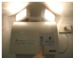
รูปที่ 13 การตรวจสอบสภาพความพร้อมใช้ของระบบไฟฉุกเฉินในโรงพยาบาล
