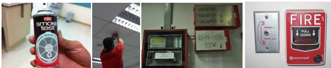
รูปที่ 14 การตรวจสอบสภาพความพร้อมใช้ของระบบสัญญาณแจ้งเหตุเพลิงไหม้
