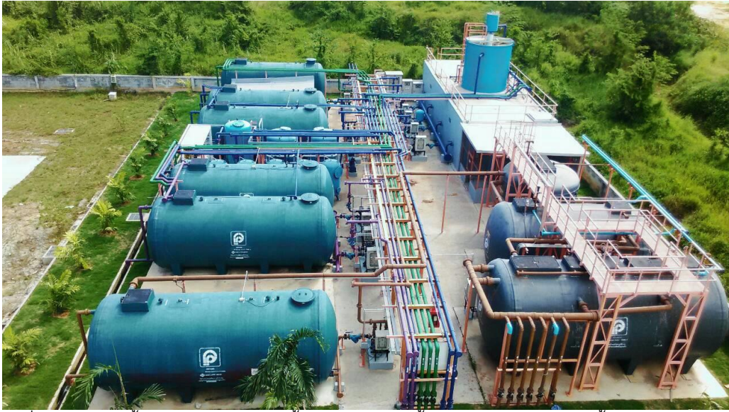
(ภาพที่ 13) โรงผลิตน้ำประปา ระบบบำบัดน้ำเสีย ระบบผลิตน้ำรีไซเคิล และระบบผลิตน้ำฝนโรงพยาบาลตึกนก
