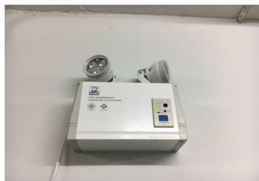
ภาพที่ 1-12 อุปกรณ์ส่องสว่างฉุกเฉิน (Emergency Light)
